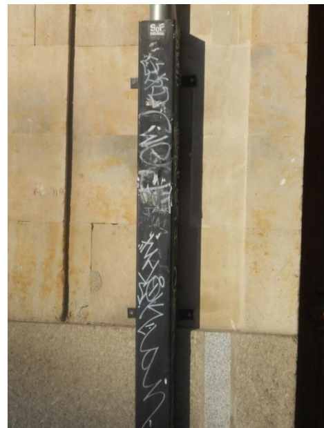
Añadidos (bajantes/canalones, rótulos, armarios- cajas registro, otros).
