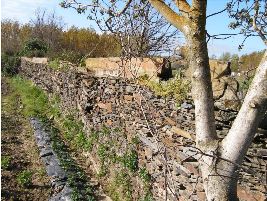
Muro tradicional de piedra conservado entre la noria y el río, al que se le añadió un canal de riego en su coronación.
