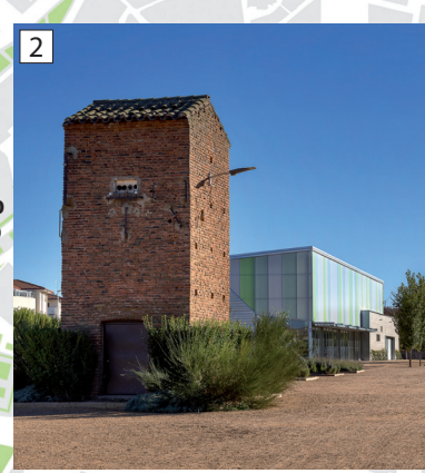
Torre eléctrica y lonja en Huertos Urbanos. Foto de Santiago Santos.
