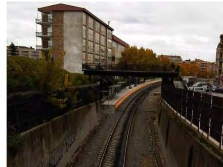
Paso superior en Apeadero Renfe
