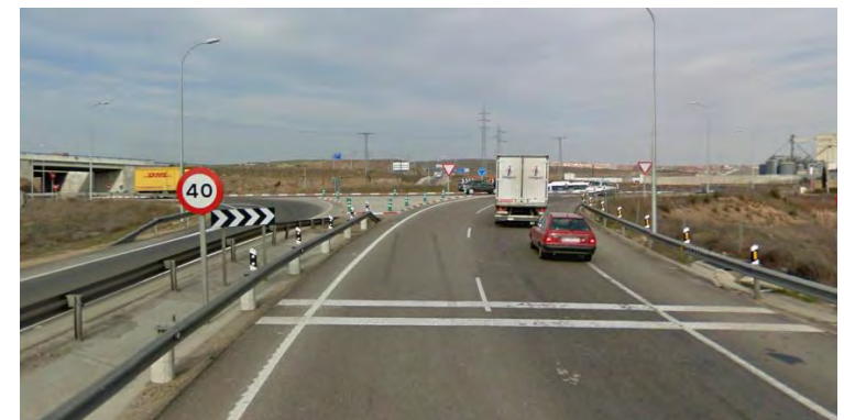
Cruce entre la A-66 y la N-620
