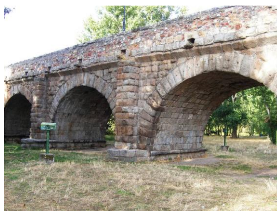
Ilustración 63. Vista parcial del Puente Romano de Salamanca.
