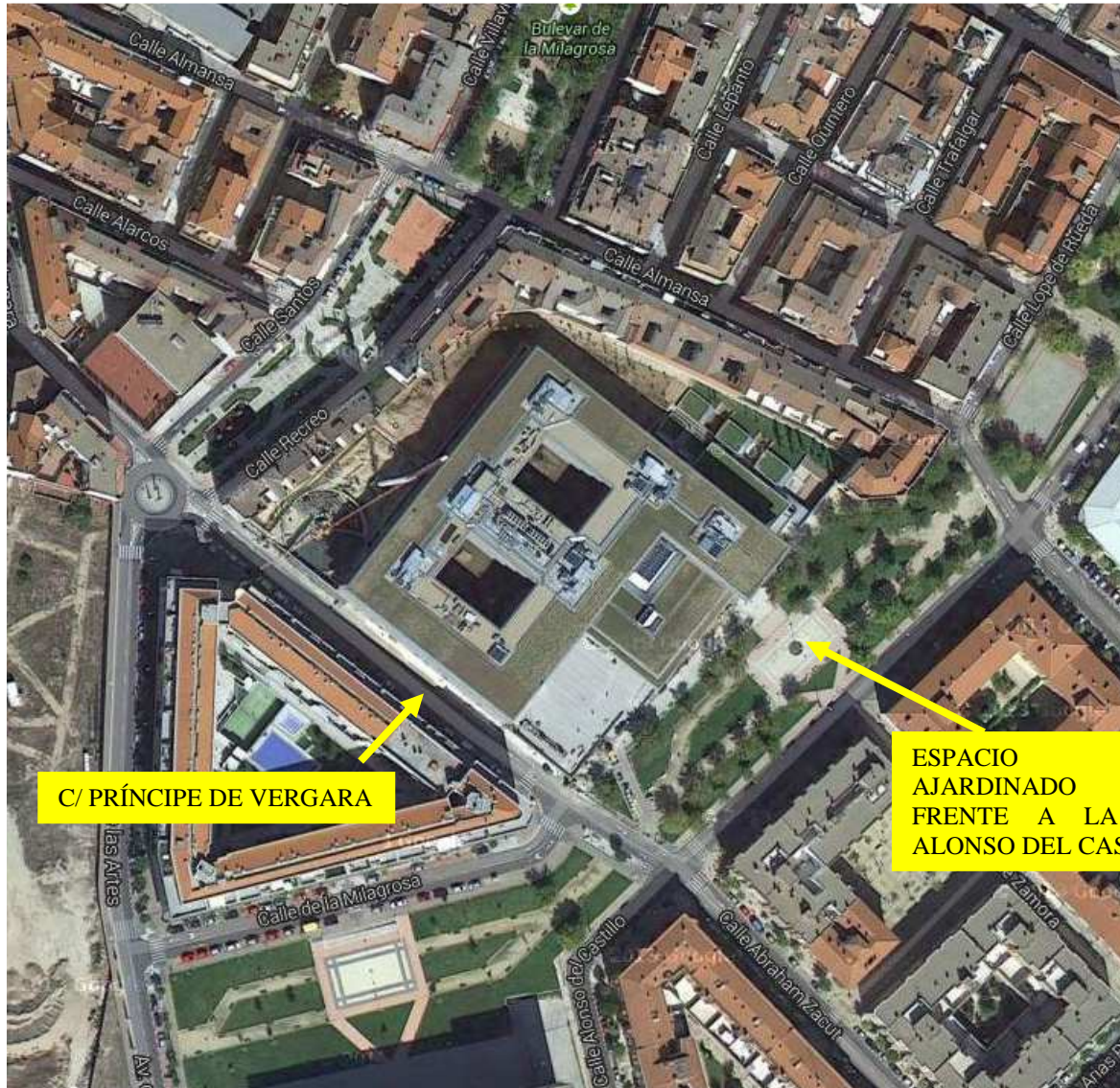
Imagen nº 7: Vista aérea fase construcción.
