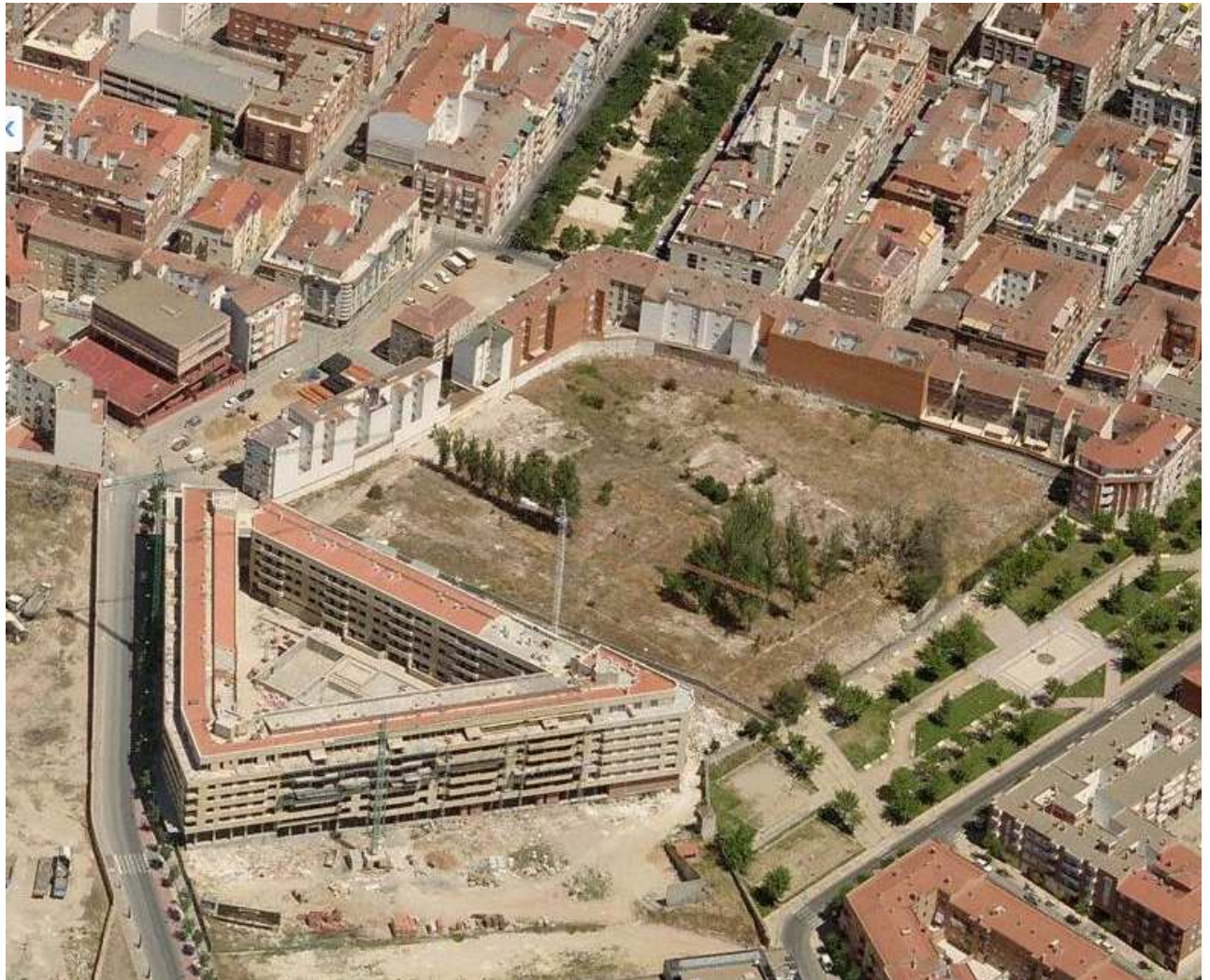
Imagen nº 6: Vista aérea estado inicial.
