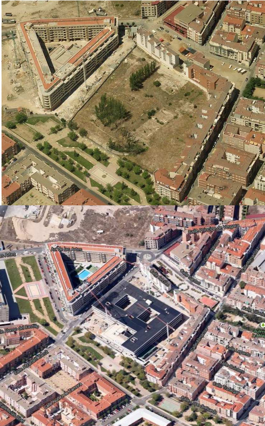
Imágenes nº 8 y 9: Vistas aérea inicial y en fase construcción.
