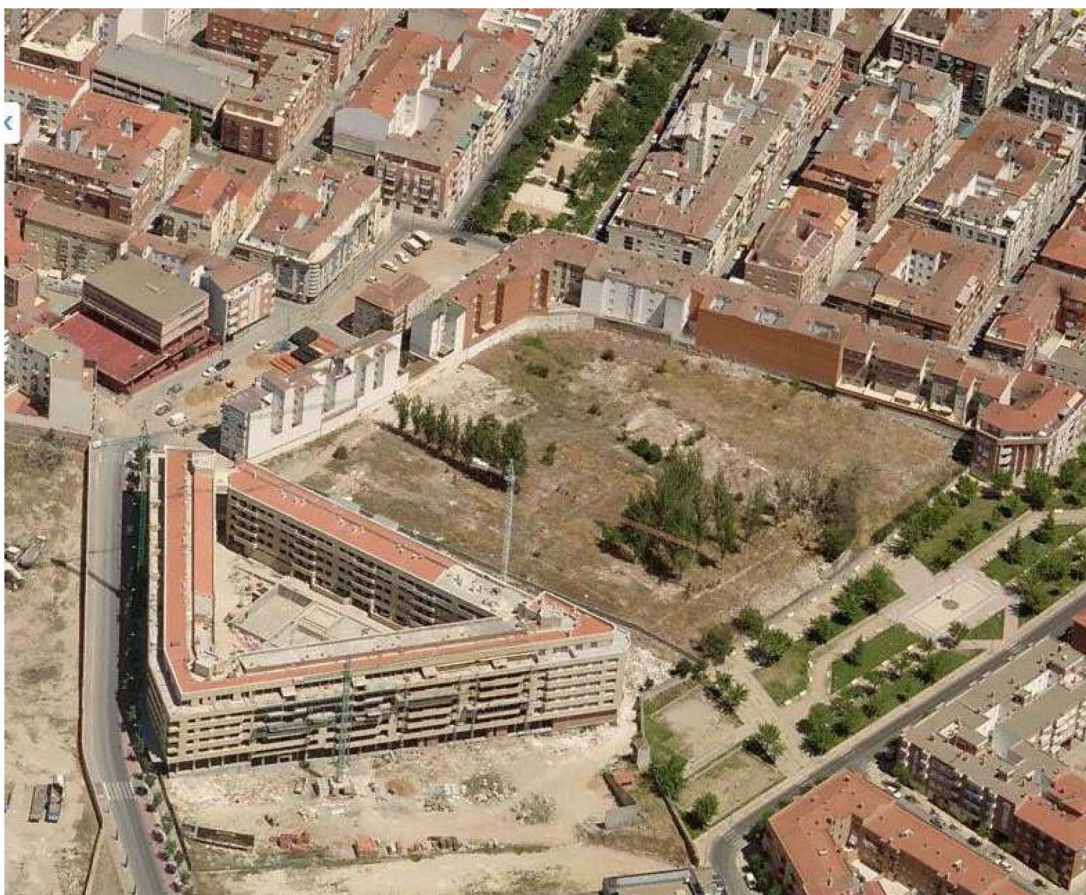
Imagen nº 6: Vista aérea estado inicial.
