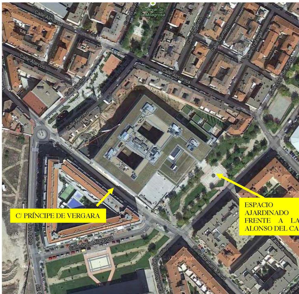
Imagen nº 7: Vista aérea fase construcción.
