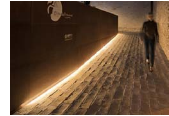
IL.2 | LUMINARIA LINEAL EMPOTRADA EN SUELO
