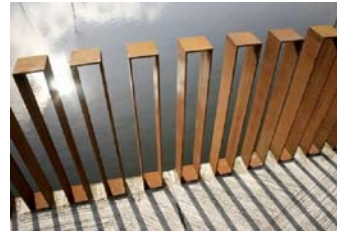
CI.2 | BARANDILLA METÁLICA PROTECCIÓN
