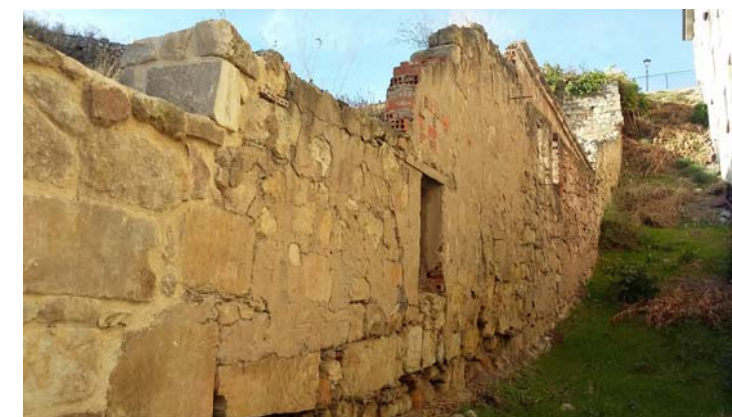
ZONA 0 | PUENTECILLO DE LA ALBERCA ESTADO ACTUAL
