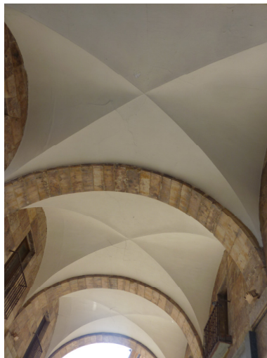
Bóvedas sobre escalera de Toro
