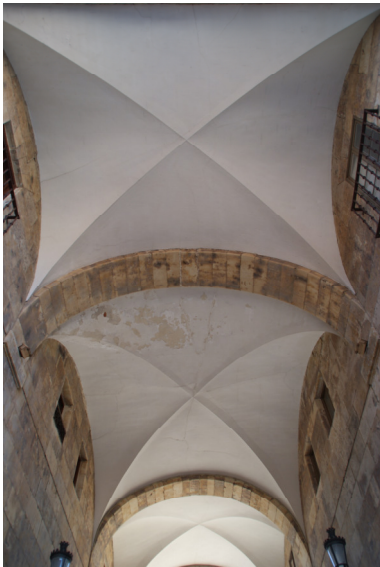
Bóveda de escalera entre soportales
