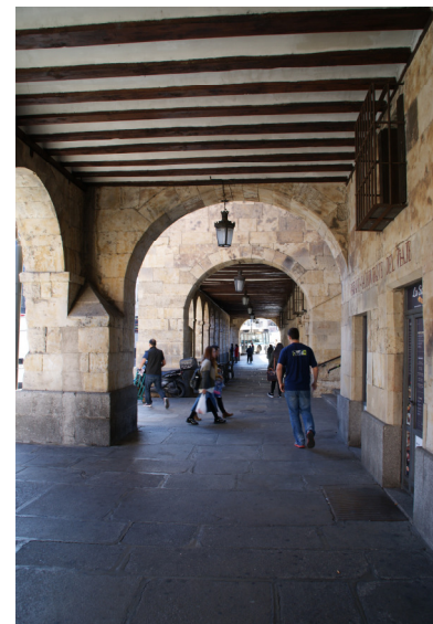
Soportal del lado derecho y encuentro con escalera
