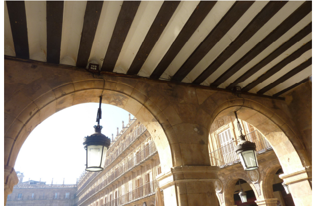
Farolas del alumbrado público colocadas en todos los casos en arcos de fachada exterior
