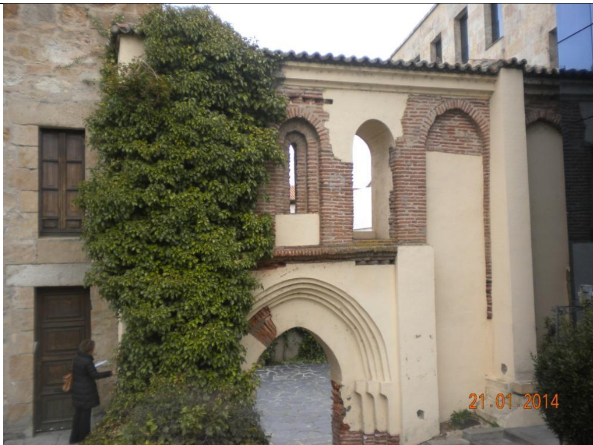
Foto 1. Reconstrucciones con ladrillo hueco doble y mortero de cemento en fachada sur
