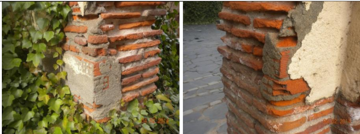
Foto 1. Reconstrucciones con ladrillo hueco doble y mortero de cemento en fachada sur
