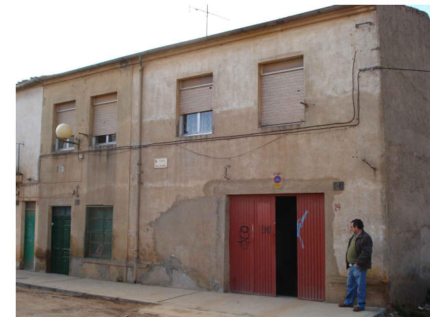
Fachada principal _ calle San Justino, 6
