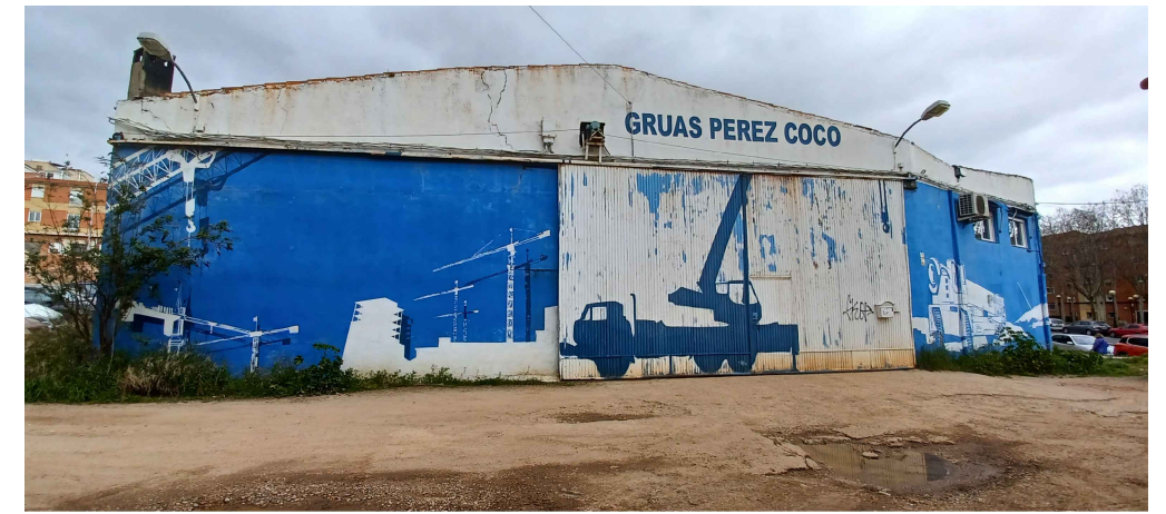
Fachada principal _ calle San Justino
