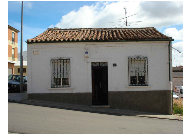
Fachada principal _ calle Santa Rita
