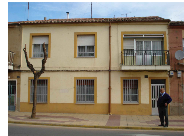
Fachada principal _ calle Regato del Anís, 30
