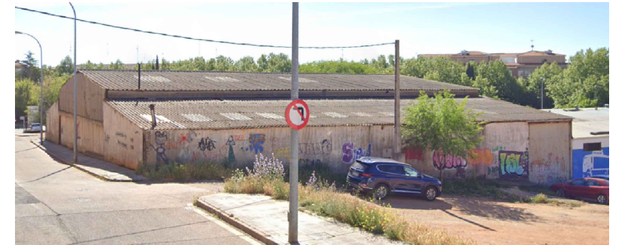
Fachada principal _ calle Santa Bárbara
