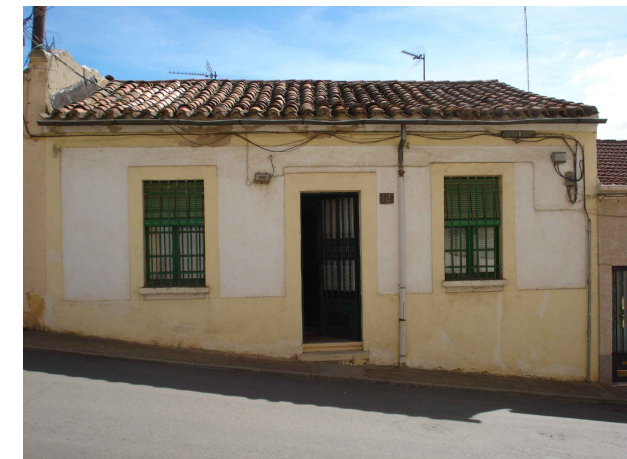
Fachada principal _ calle Santa Rita
