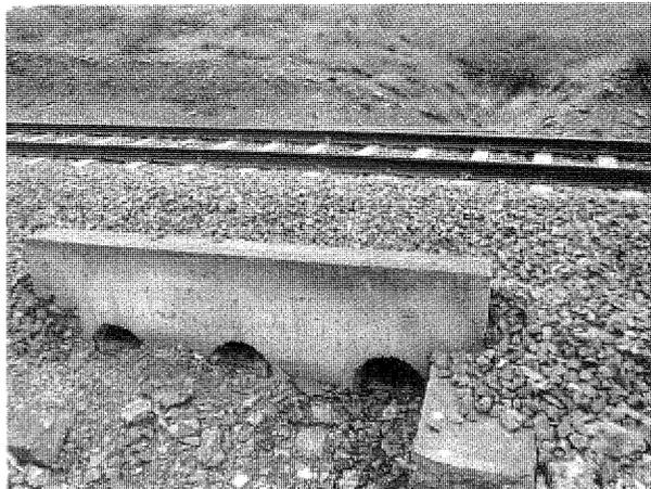
Para dar continuidad a esta obra de drenaje transversal de la vía a lo largo de la Plataforma, se colocará un tubo de hormigón armado  $\text{Ø}1800$  mm, hasta conectar con la obra de drenaje principal descrita anteriormente.
