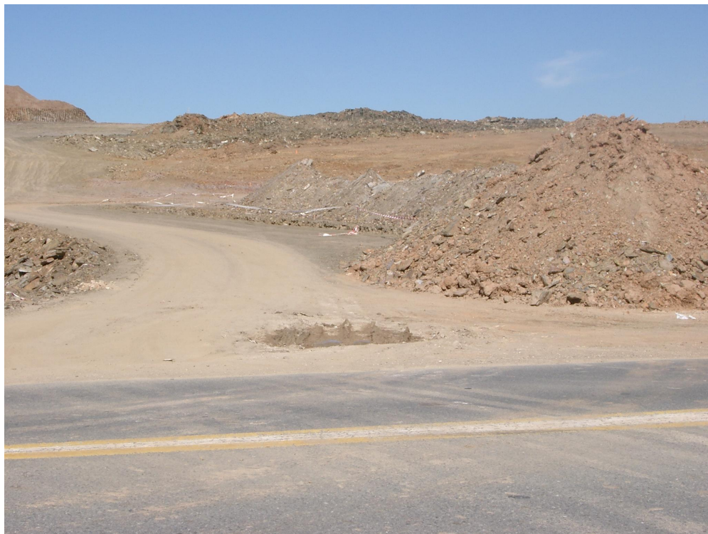
Foto 19 Sector 77 (en ejecución)
