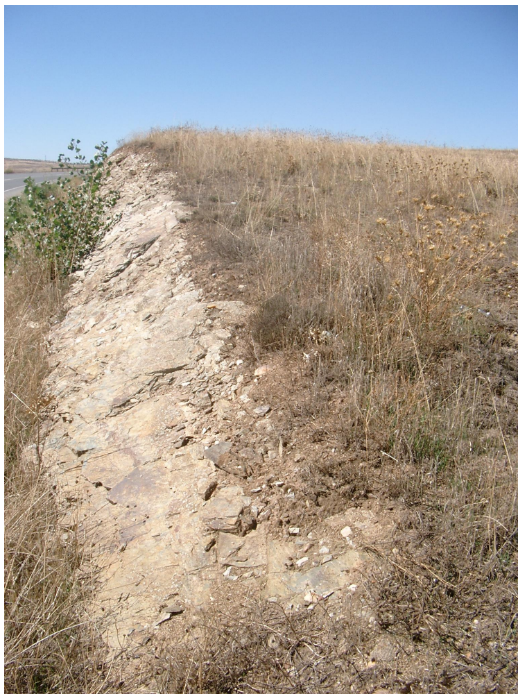
Foto 4 Límite sur del Sector. Talud de pizarras
