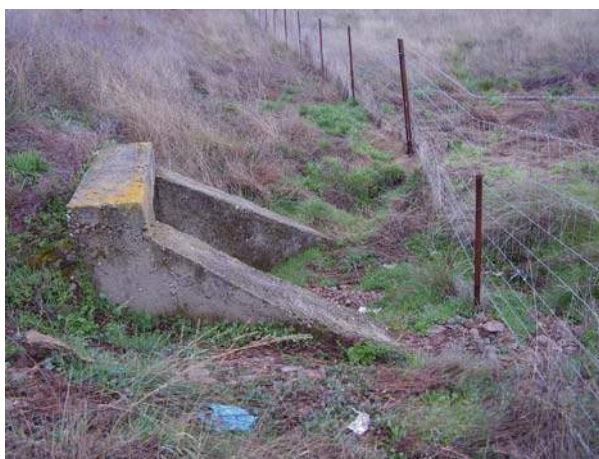
Detalle de la obra de fábrica que conduce las aguas del regato de Cantimporras bajo la carretera de acceso al aparcamiento del Recinto Ferial
