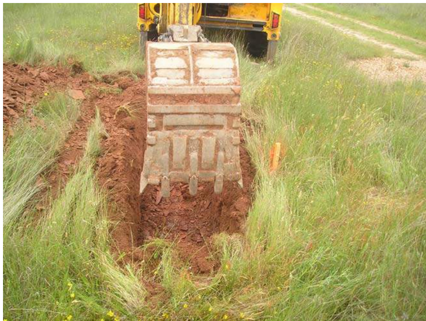
Momento de realización de las calicatas en el ámbito de estudio.
