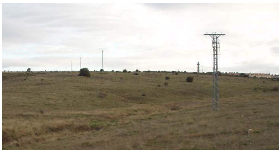
Línea de 45 kV.
