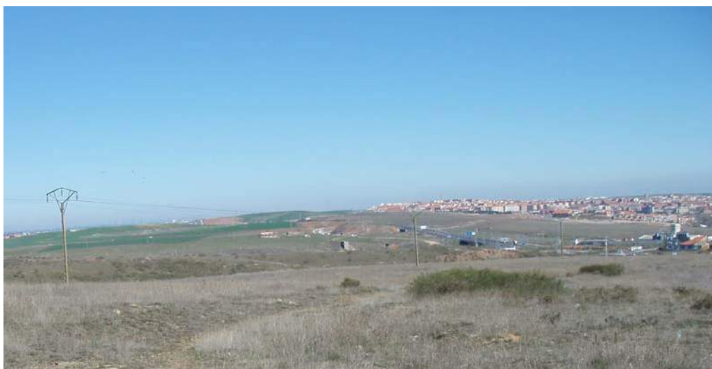
Línea de 13,2 kV.
