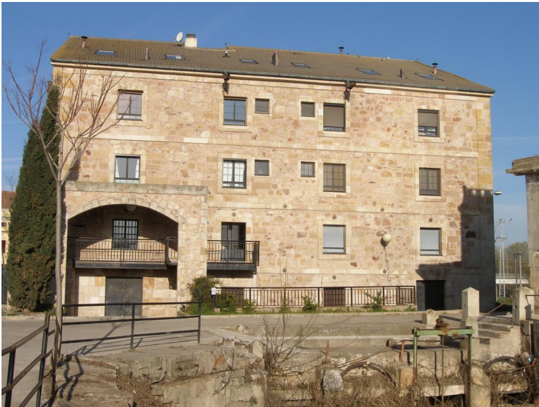
-Vista general de la fachada del edificio catalogado del antiguo Molino de Tejares rehabilitado funcionalmente como edificio de viviendas.
