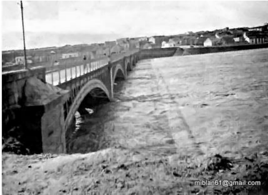
-Imagen de una riada del Tormes en el Puente de Enrique Estevan.
