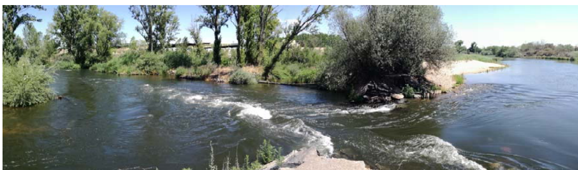
4 Imagen de la pesquera de Tejares en la zona colapsada. Fuente: Propia
