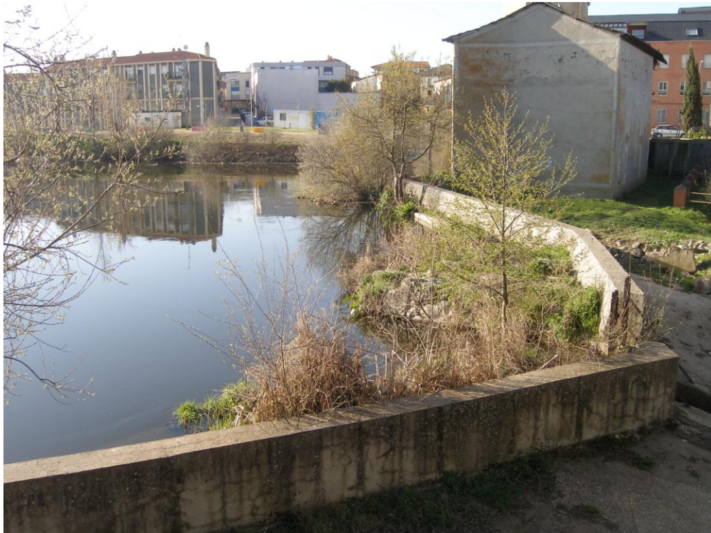
Plataforma en terraza sobre la pesquera superpuesta para el tránsito sobre las estructuras originales del tajamar y el remate actual del azud.
