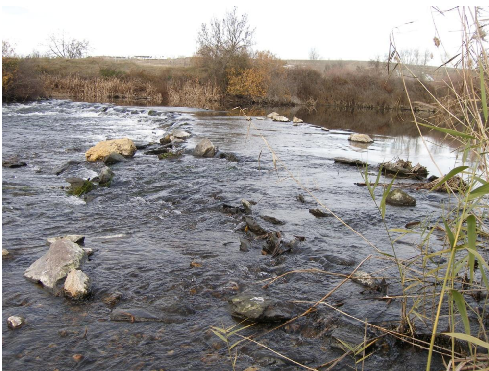
-Perspectivas desde el sur donde se aprecia la anchura y fábricas de la pesquera.
