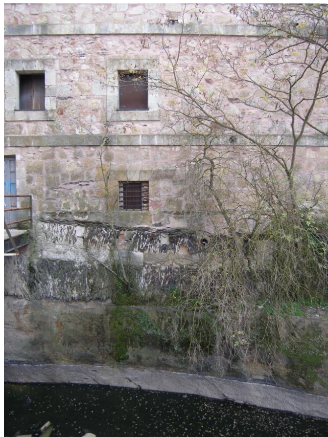
-Superposición estratigráfica de fábricas constructivas de la antigua aceña de Tejares en cuya base se manifiesta el empleo de materiales constructivos propios del lugar como la pizarra.
