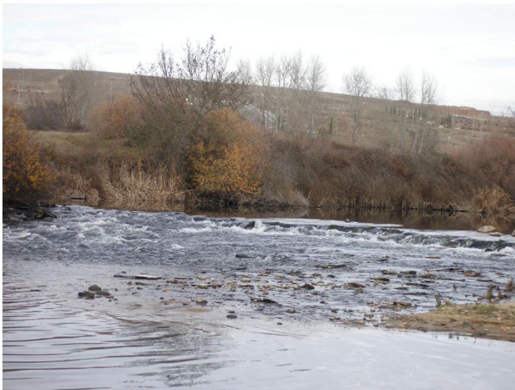
-Vista general desde el suroeste del tramo de pesquera recayente a Tejares.
