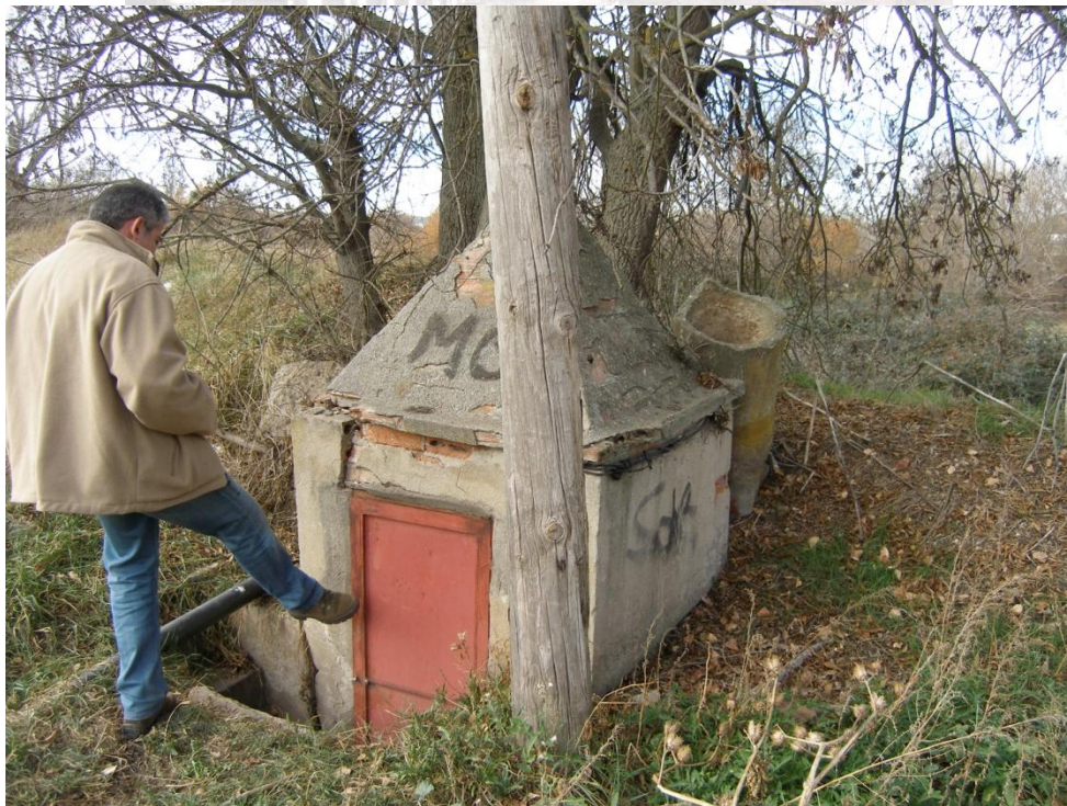
Pozo de registro situado al final del terraplén.
