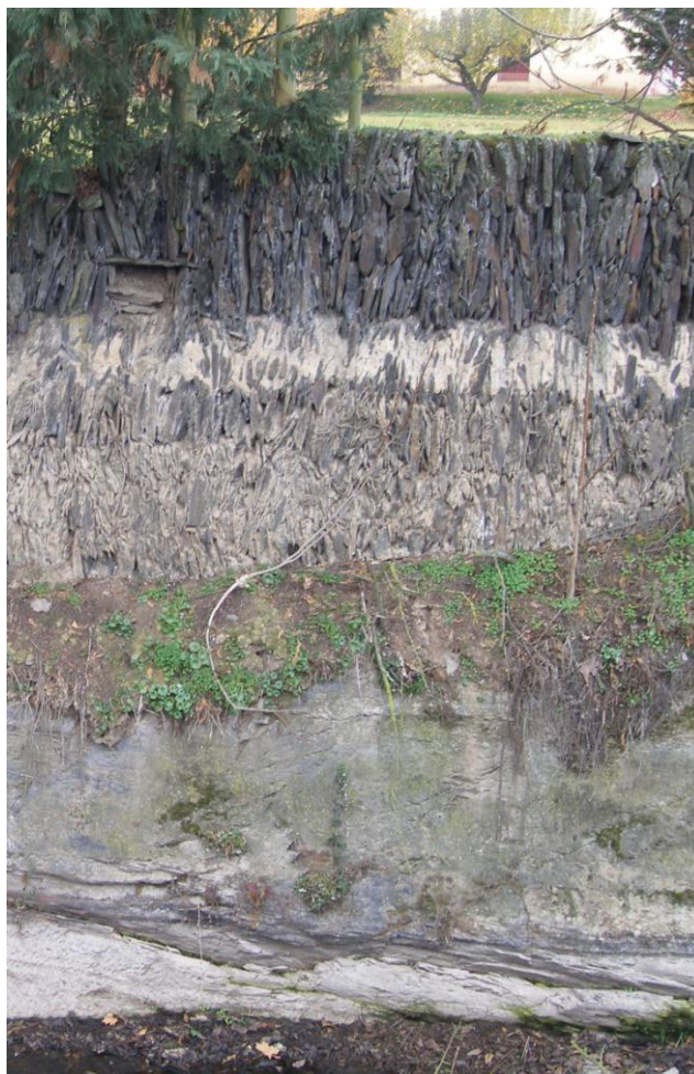
-Detalle del corte del canal con la superposición de elementos de fábrica.
