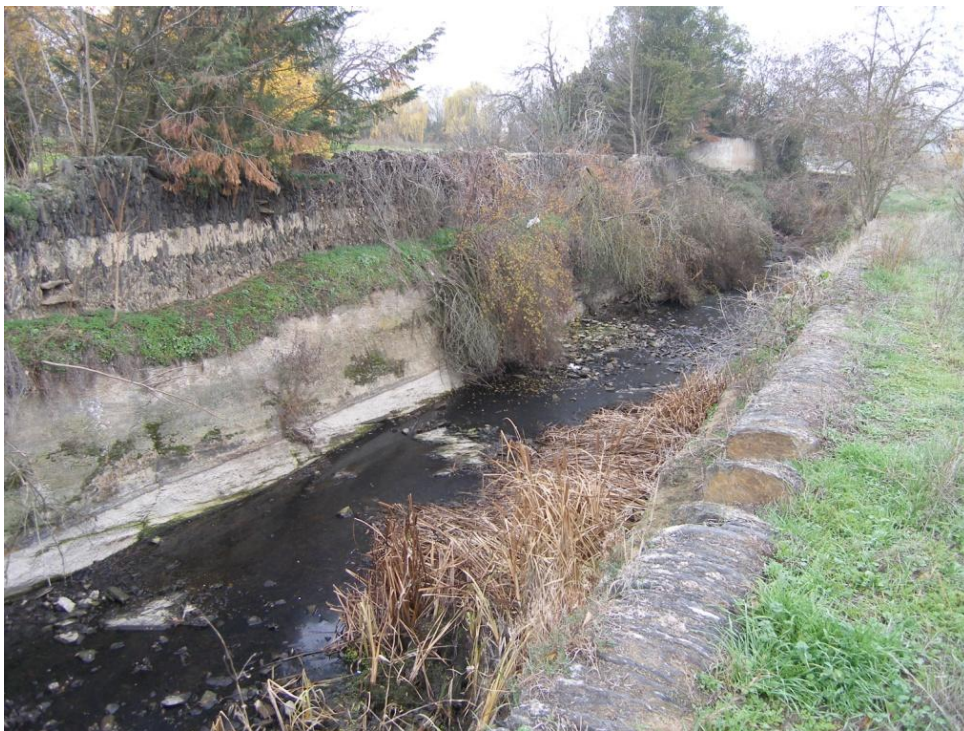
-Vista parcial de uno de los tramos más atractivos del canal con superposición de muro tradicional de pizarras sobre el vaso abierto en el sustrato geológico.
