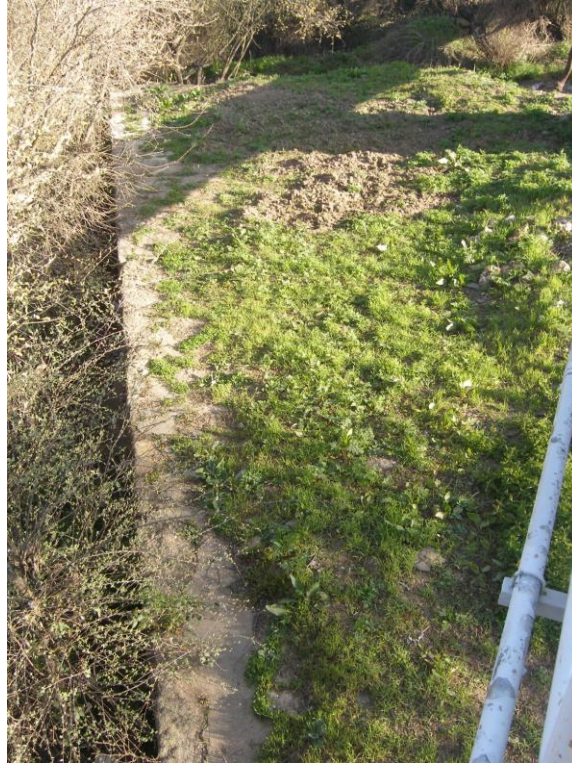
-Detalle de muro anguloso semienterrado de los refuerzos del canal aliviadero de la fábrica de luz.
