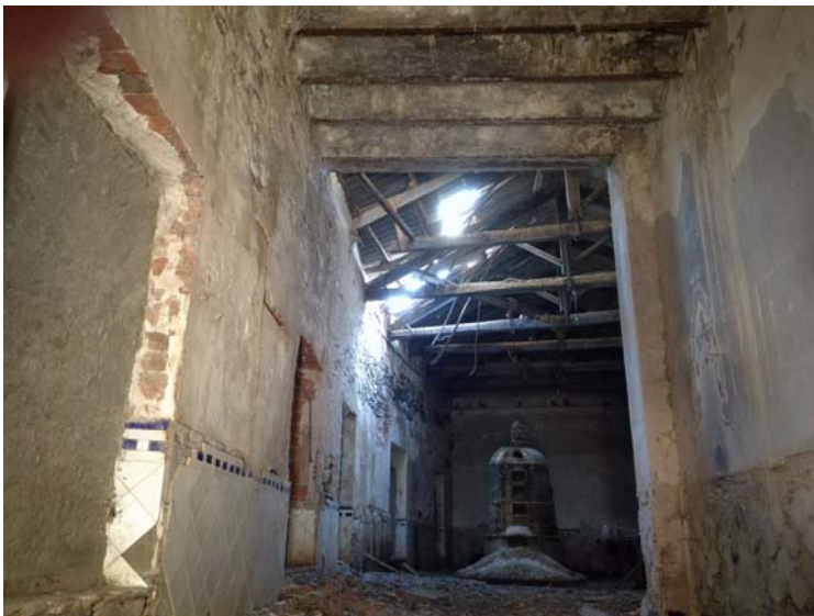
10 Vista interior desde acceso hacia la cubierta de la nave principal. Fuente: Propia
