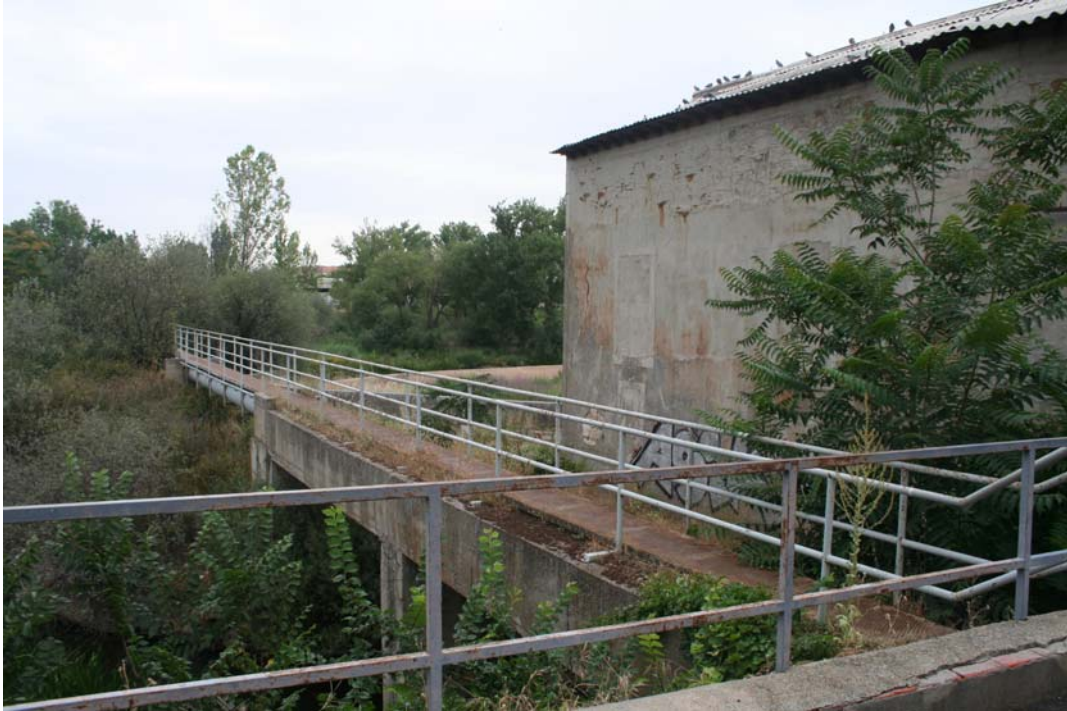
5 Vista de la canalización de saneamiento y pasarela junto a la fábrica de la luz. Fuente: Propia
