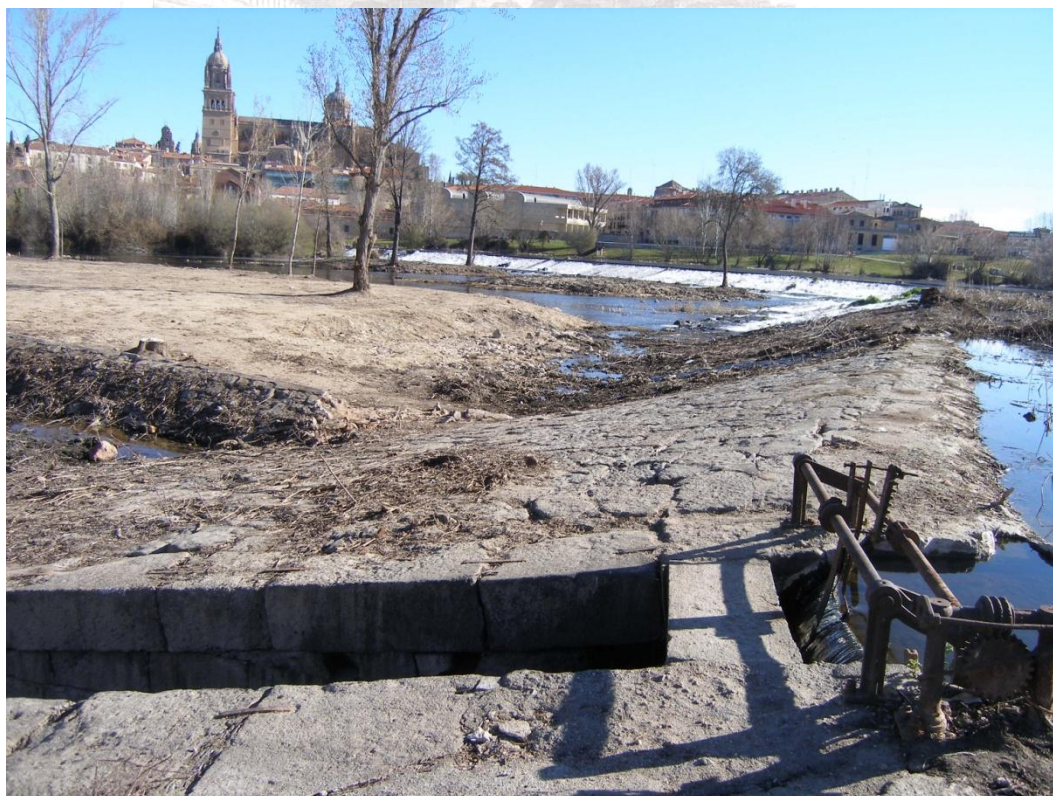
-Detalle de la pesquera del Tormes y el canal aliviadero la aceña del Arenal con excelente fábrica de sillería pétreo.
