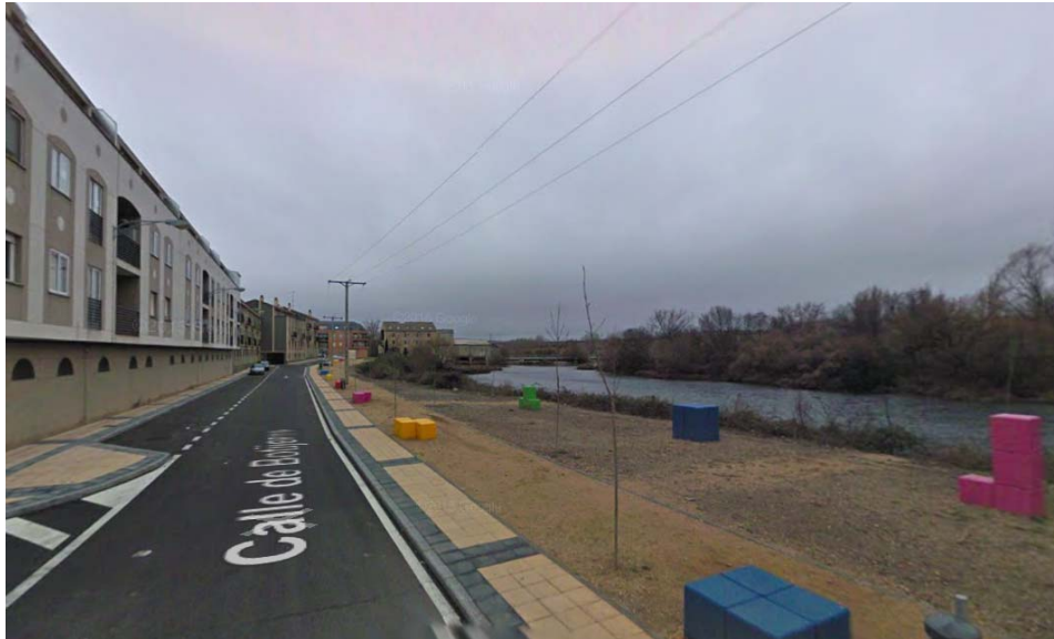
7 Imagen de la calle Botijeros poco después de su urbanización de 2008. Fuente: Google Streetview
