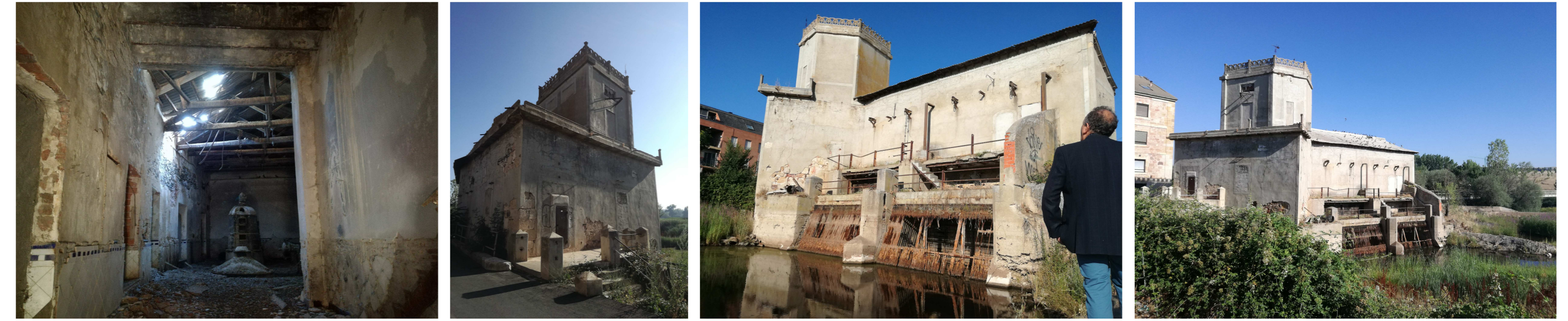
Imágenes del estado actual
