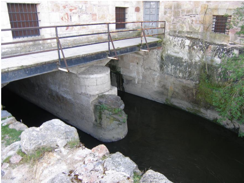
-Detalle de las fábricas originales del espaldón de los cárcavos de la antigua aceña de Tejares.
