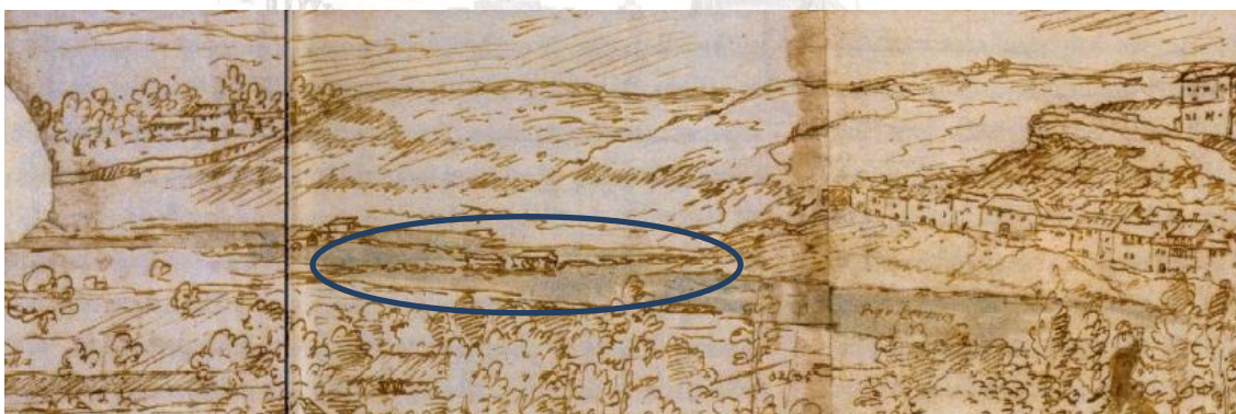
Representación de Wyngaerde de 1570 de una aceña con su azud en este sector del río.
