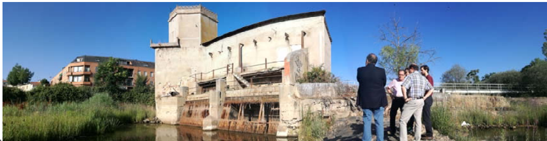
2 Vista de la fábrica desde el cauce. Fuente: Propia
