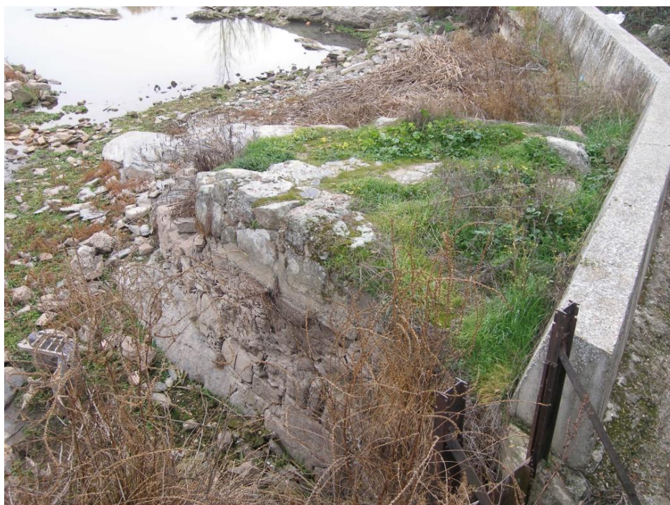
-Detalle de las fábricas del tajamar que flanquea el canal aliviadero de la aceña de Tejares.
