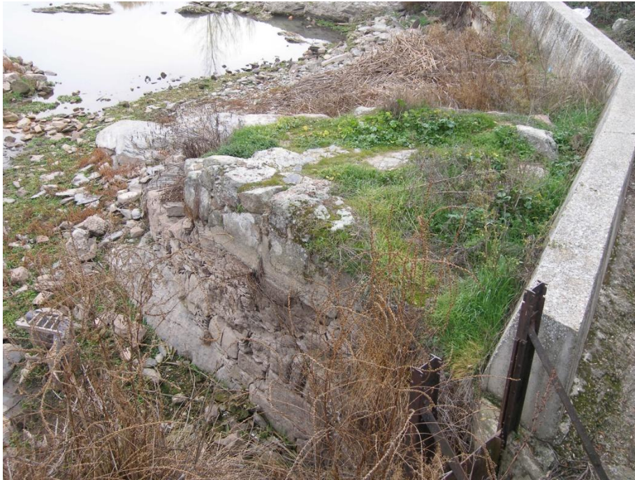
-Detalle de las fábricas del tajamar que flanquea el canal aliviadero de la aceña de Tejares.
