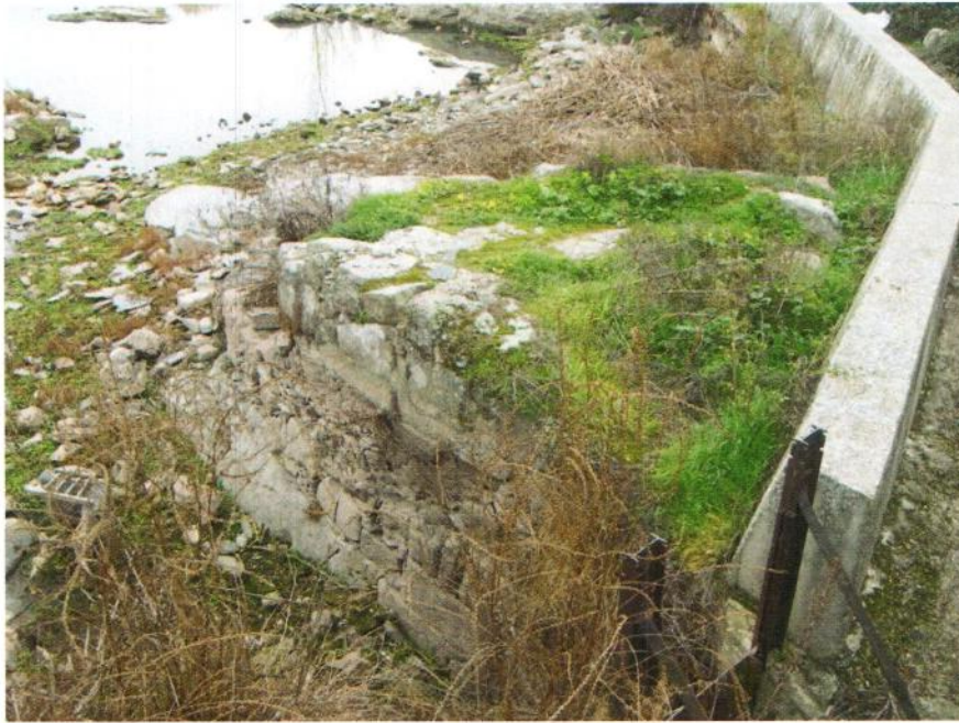
-Detalle de las fábricas del tajamar que flanquea el canal aliviadero de la aceña de Tejares.
