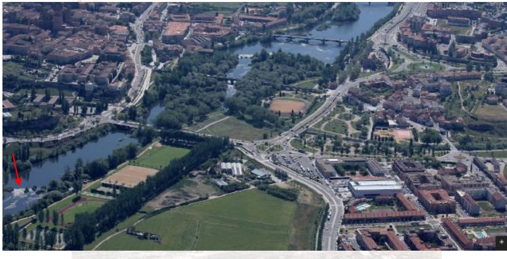
-Vista aérea reciente extraída de Google Maps donde se aprecia el salto de agua producido por esta barrera a la izquierda de la imagen.
