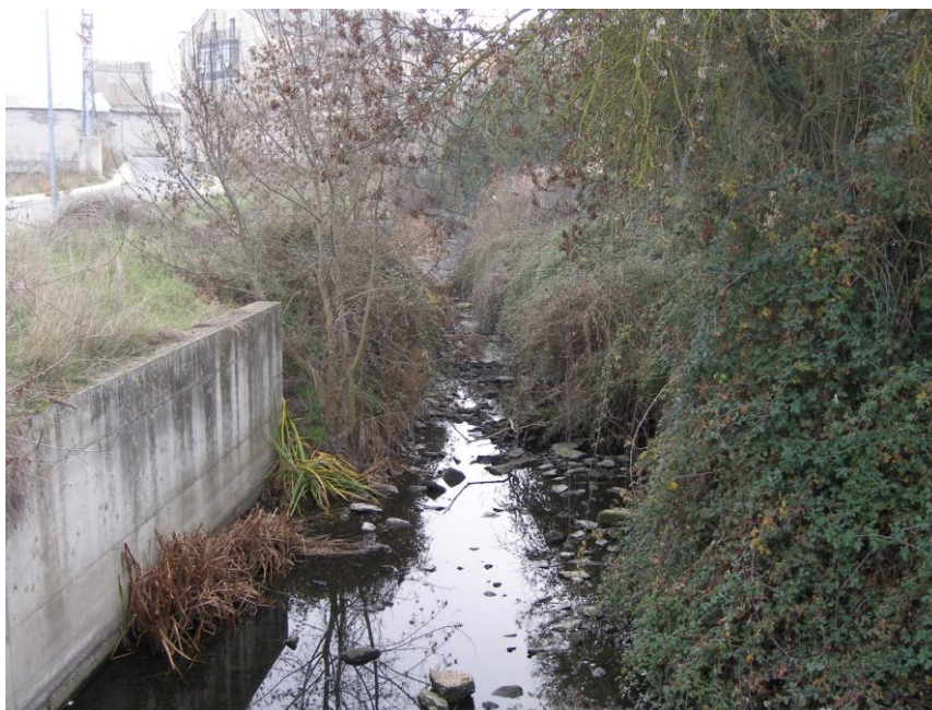
-Vista del tramo occidental del canal donde la vegetación y el muro de contención de hormigón desvirtúan en parte su percepción.
