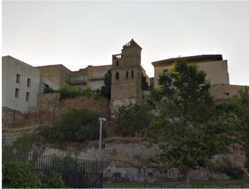
16 Vista de la torre en las "Casas del Parque" de la USAL utilizada para la conducción eléctrica desde la fábrica de la luz de Tejares. Fuente: Goglemaps
