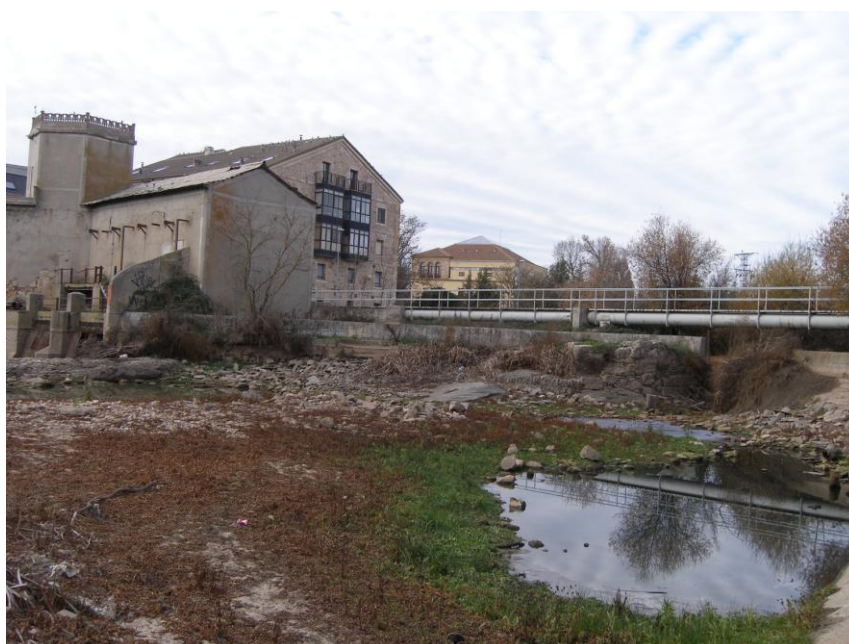
-Vista parcial de la Fábrica de la Luz (a la izquierda de la imagen) junto a otras instalaciones inmuebles
