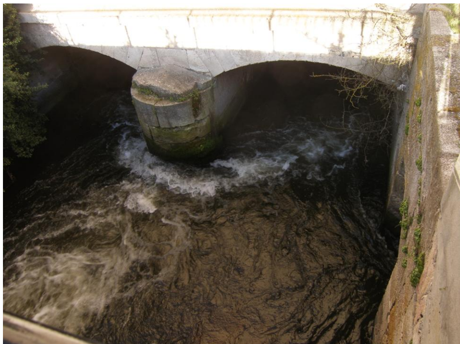
-Cárcavo (socaz) del molino y entrada del desagüe hacia el canal aliviadero (a la derecha de la imagen).
