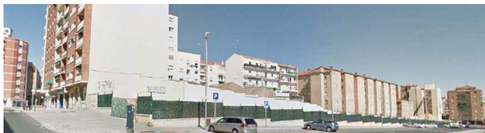
Figura. Vista de la situación actual en el ámbito desde la esquina c/Víctimas del Terrorismo con c/Alfonso de Castro.
