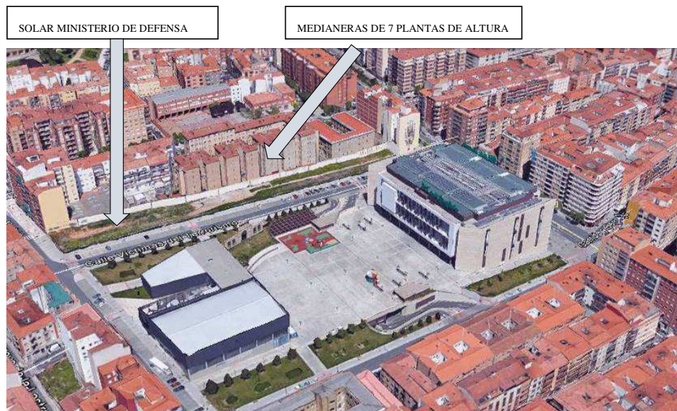
Figura. Vista 3D de la situación actual en el ámbito de la Modificación (Google Maps).
