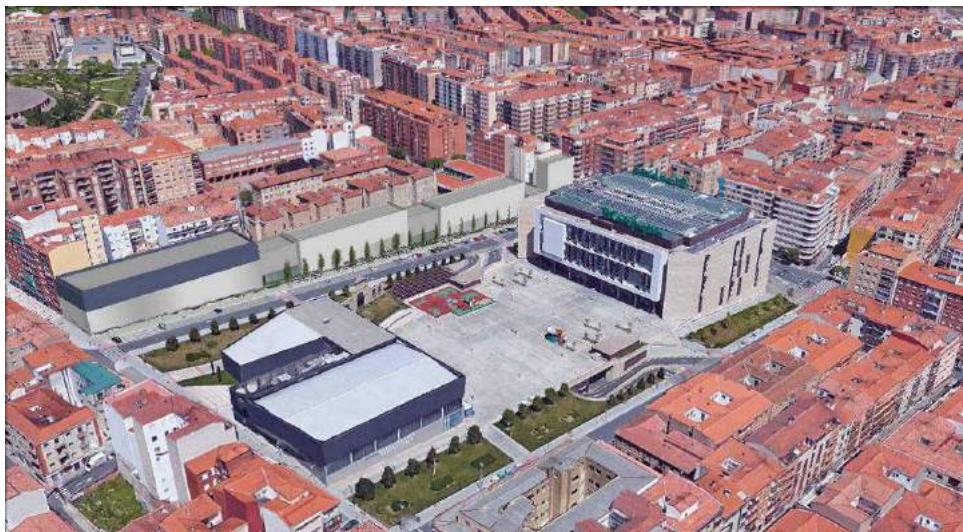
Figura. Vista 3D de la propuesta de ordenación detallada de la Modificación (Google Maps).
