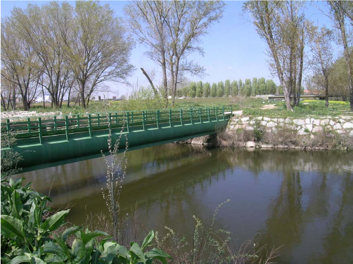
ULTIMO TRAMO CANALIZADO DEL ZURGUÉN
