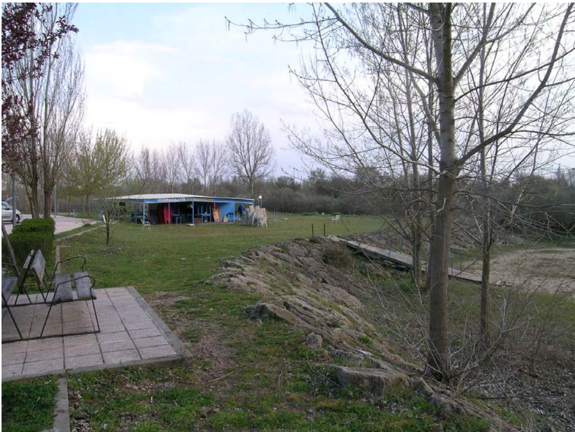
ALDEHUELA: TALUD QUE DELIMITA LA RIBERA Y ESTABILIZA LA PLATAFORMA SUPERIOR
