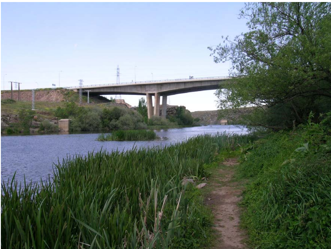
PUENTE SOBRE LA RONDA NOROESTE
