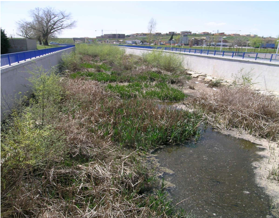
PENÚLTIMO TRAMO CANALIZADO DEL ZURGUÉN
