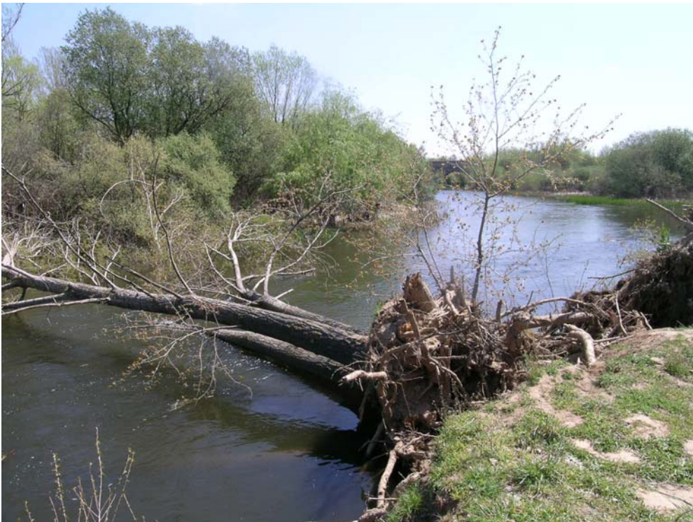
ENTORNO PUENTE ROMANO. RETROCESO DE LA ORILLA POR EROSIÓN
