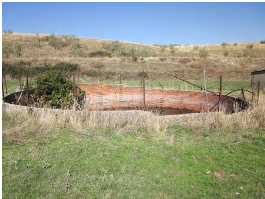
Pozo de 11 m. de diámetro y 5 m. de profundidad
