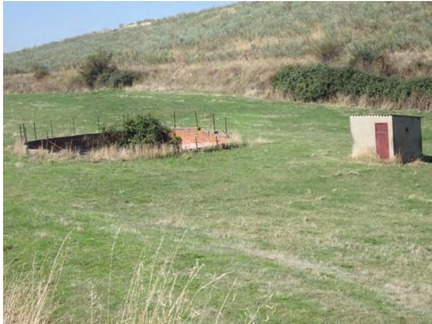
Vista general del pozo y de la caseta
