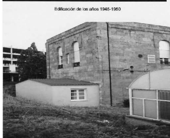
Añadidos a demoler por su baja calidad
