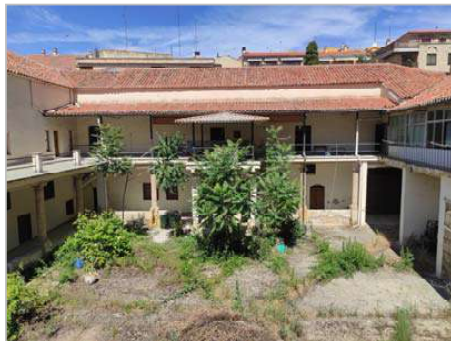
Figs. 17 y 18.- Dos vistas del claustro norte, desde el este y sureste respectivamente. Se aprecia el tejadillo que cubre el lado oeste del piso superior, la galería acristalada del lado septentrional y el antepecho y las columnas del piso inferior.
