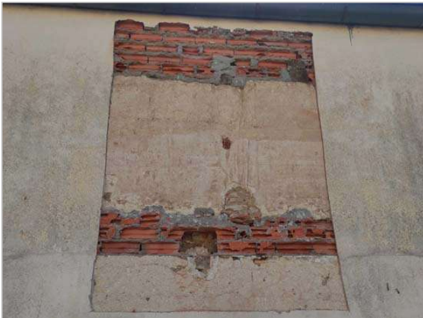
Fig. 91.- Fotografía general de esta cata muraria donde se documentó de nuevo el muro de tapial enfoscado con mortero, un agujal y las dos franjas de ladrillo hueco.
