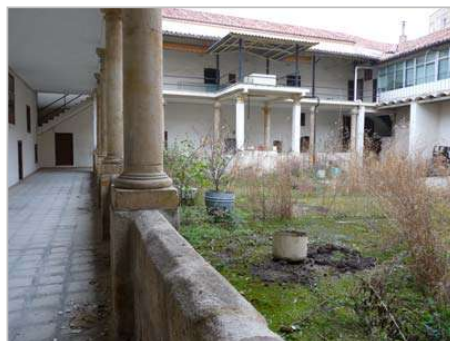
Figs. 17 y 18.- Dos vistas del claustro norte, desde el este y sureste respectivamente. Se aprecia el tejadillo que cubre el lado oeste del piso superior, la galería acristalada del lado septentrional y el antepecho y las columnas del piso inferior.
