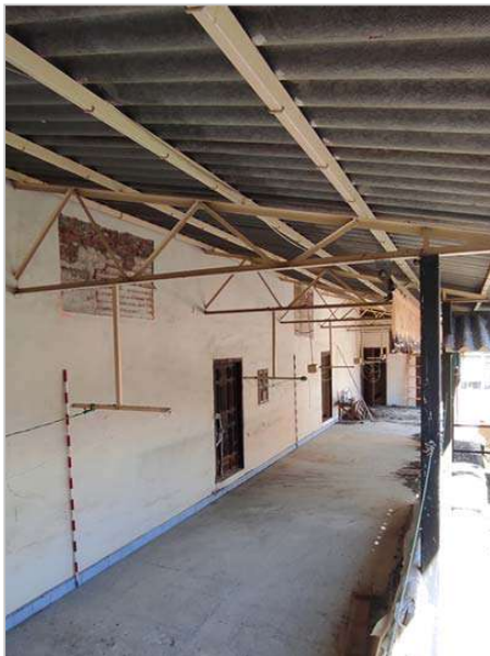
Figs. 92 a 94.- Arriba, localización de las dos catas bajo el tejadillo de uralita que cubre este ala. A la derecha arriba, cata 5 y abajo cata 6. En ambas se documentó el muro de tapial con machones de ladrillo.
