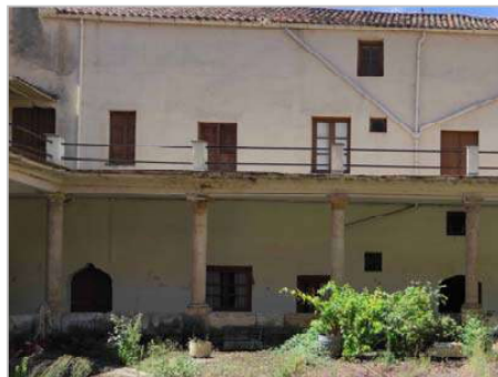
Figs. 22 y 23.- Izquierda, lado norte del claustro con una galería acristalada y lado oeste, cubierto con un tejadillo de uralita. Derecha, lado oriental con el piso superior sin cubrir. En ambas fotografías se aprecia el forjado de vigas de hierro que descansan sobre las columnas del piso inferior.
