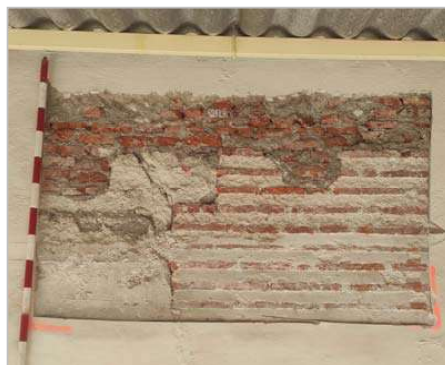
Figs. 92 a 94.- Arriba, localización de las dos catas bajo el tejadillo de uralita que cubre este ala. A la derecha arriba, cata 5 y abajo cata 6. En ambas se documentó el muro de tapial con machones de ladrillo.
