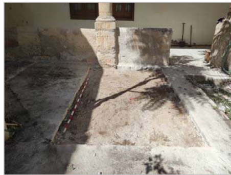
Figs. 26 y 27.- Trabajos de picar con martillo hidráulico el actual suelo del patio constituido por una solera de hormigón de unos 10 cm de grosor y su capa de asiento de arena de unos 4-5 cm (UE. 1), capa fotografiada en la foto de la derecha.
