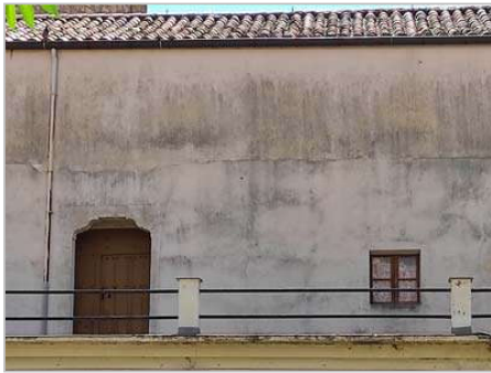
Figs. 78 y 79.- Izquierda, muro este donde se observa la línea que podría estar indicando la antigua existencia de un forjado de madera. Derecha, plano de sección del piso superior de la planta oeste, los círculos rojos están marcando la diferencia de grosor que existe en estos muros.
