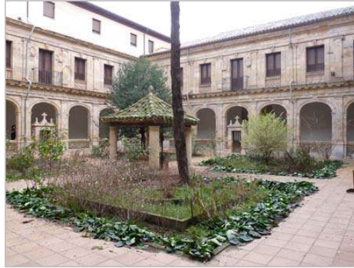
Fig. 10.- Fotografía de la esquina noreste del claustro.
