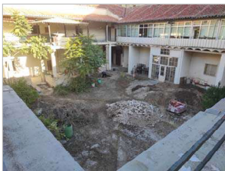
Figs. 22 y 23.- Izquierda, lado norte del claustro con una galería acristalada y lado oeste, cubierto con un tejadillo de uralita. Derecha, lado oriental con el piso superior sin cubrir. En ambas fotografías se aprecia el forjado de vigas de hierro que descansan sobre las columnas del piso inferior.
