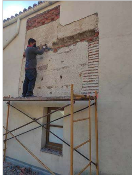
Figs. 81 a 83.- Dos fotografías del proceso de realización de la cata muraria y lo documentado en la misma; un muro de tapial con machones de ladrillos en el que se ven las improntas de unos mechinales donde apoyaría la estructura de madera de un tejadillo a un agua.
