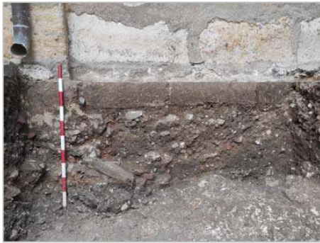
Figs. 54 y 55.- En la imagen de la izquierda, base de sillares de arenisca (UE. 32) del antepecho de la galería, asentada directamente sobre el nivel UE. 34. En la de la izquierda, fotografía del muro desde el norte.
