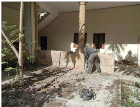
Figs. 26 y 27.- Trabajos de picar con martillo hidráulico el actual suelo del patio constituido por una solera de hormigón de unos 10 cm de grosor y su capa de asiento de arena de unos 4-5 cm (UE. 1), capa fotografiada en la foto de la derecha.
