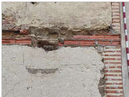
Figs. 88 y 89.- Izquierda, banda de ladrillo hueca donde se retiró alguno para comprobar que detrás también estaban los mechinales documentados en la cata 1. Derecha, parte inferior de la cata donde se descubrió un posible armarito u hornacina.
