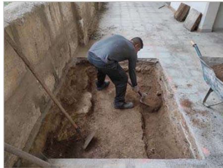
Figs. 64 y 65.- Izquierda, la capa de asiento de mortero de cal de las baldosas de arenisca a medio excavar. Derecha, trabajos de excavación del nivel de tierra (UE. 104) documentado bajo la anterior capa de asiento.
