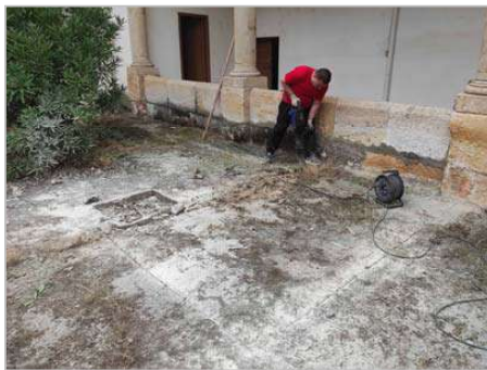
Figs. 60 y 61.- Izquierda, situación del sondeo 4 y trabajos de picado de la solera de hormigón. Derecha, pavimentos de cantos documentado a una profundidad unos 15 cm y que no fue levantado.
