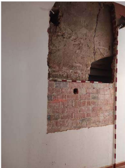
Figs. 97 y 98.- A la izquierda la cata B donde se documentó el muro de tapial y un vano de una puerta abierta en el mismo. A la derecha el muro oriental de la panda oeste donde tampoco se documentó diferencia de grosor en su alzado.
