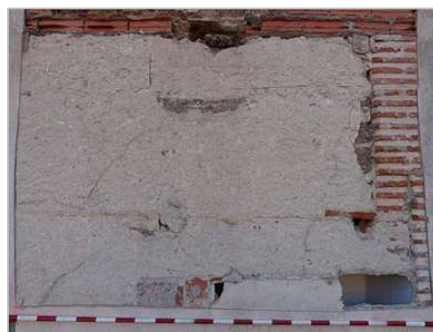
Figs. 88 y 89.- Izquierda, banda de ladrillo hueca donde se retiró alguno para comprobar que detrás también estaban los mechinales documentados en la cata 1. Derecha, parte inferior de la cata donde se descubrió un posible armarito u hornacina.
