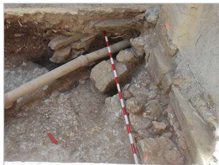
Figs. 32 y 33.- Detalle de la pared S de la canalización (izquierda) y de la base de sillares y la cimentación de mampostería del muro antepecho de la galería (derecha).
