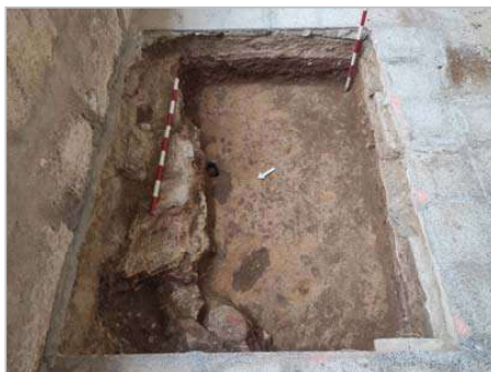
Figs. 66 y 67.- Izquierda, cimentación (UE. 103) del antepecho de la galería y la capa de argamasa (UE. 105) sobre la que se asentaba. Derecha, perfil oriental de la cata donde se ve el suelo actual de baldosas de gres y su capa de asiento de arena, la capa de asiento de mortero de cal del pavimento de baldosas de arenisca, el nivel de relleno de tonalidad oscura y la capa de argamasa de tonalidad anaranjada
