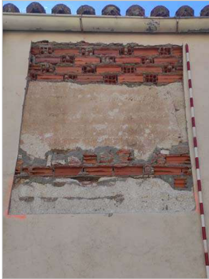
Figs. 81 a 83.- Dos fotografías del proceso de realización de la cata muraria y lo documentado en la misma; un muro de tapial con machones de ladrillos en el que se ven las improntas de unos mechinales donde apoyaría la estructura de madera de un tejadillo a un agua.
