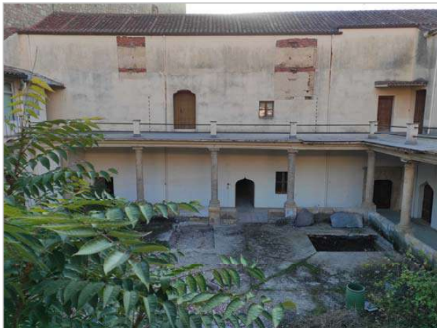
Fig. 90.- Pared E con las dos catas murarias realizadas en la misma.
