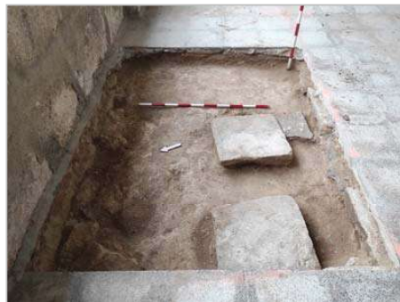
Figs. 62 y 63.- Izquierda, trabajos de picar y retirar las baldosas de gres y su capa de asiento de arena (UE.100). Derecha, las dos losas de arenisca que formarían parte de un pavimento anterior (UE. 101) asentado sobre una capa de mortero de cal nivelada (UE. 102).
