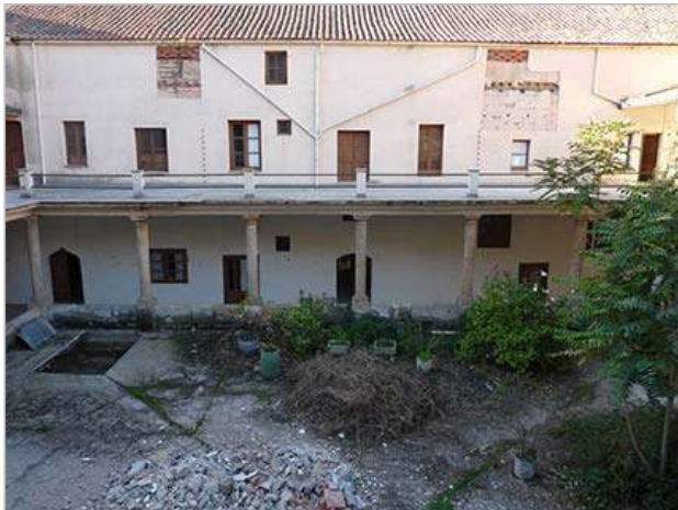
Fig. 84.- Pared S con las dos catas murarias realizadas en la misma.
