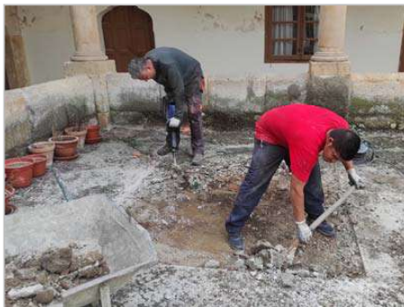
Figs. 36 y 37.- Izquierda, trabajos de picar y retirar la solera de hormigón y su capa de asiento de arena (UE. 20). Derecha, suelo de cantos y grandes losas de pizarra (UE. 21).
