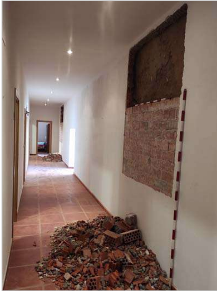
Figs. 95 y 96.- Izquierda, localización de las 2 catas trazadas en el muro E, la cata A en la mitad S (en primer plano) y la B en la mitad N (al fondo del pasillo). Derecha, la cata A donde tras retirar los ladrillos de la actual quedó a la luz el muro de tapial sin ninguna diferencia en su grosor.
