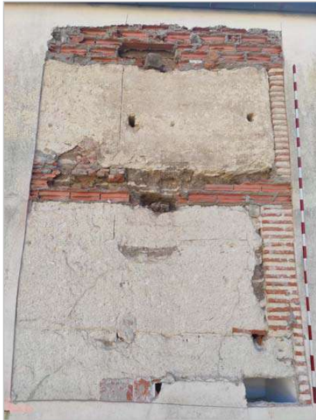
Fig. 86.- Vista general de la cata con el muro de tapial enfoscado de mortero, los machones de ladrillo macizo, la banda superior donde descansaría la estructura de la cubierta, la franja de ladrillo del medio que está tapando los mechinales donde iría la estructura de madera de un tejadillo y el hueco de abajo a la derecha posiblemente de un armarito u hornacina.
