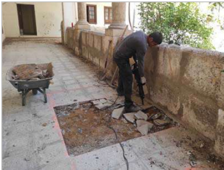
Figs. 62 y 63.- Izquierda, trabajos de picar y retirar las baldosas de gres y su capa de asiento de arena (UE.100). Derecha, las dos losas de arenisca que formarían parte de un pavimento anterior (UE. 101) asentado sobre una capa de mortero de cal nivelada (UE. 102).
