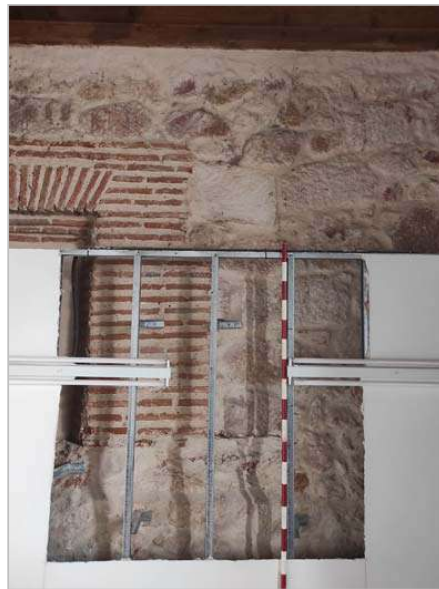
Figs. 97 y 98.- A la izquierda la cata B donde se documentó el muro de tapial y un vano de una puerta abierta en el mismo. A la derecha el muro oriental de la panda oeste donde tampoco se documentó diferencia de grosor en su alzado.
