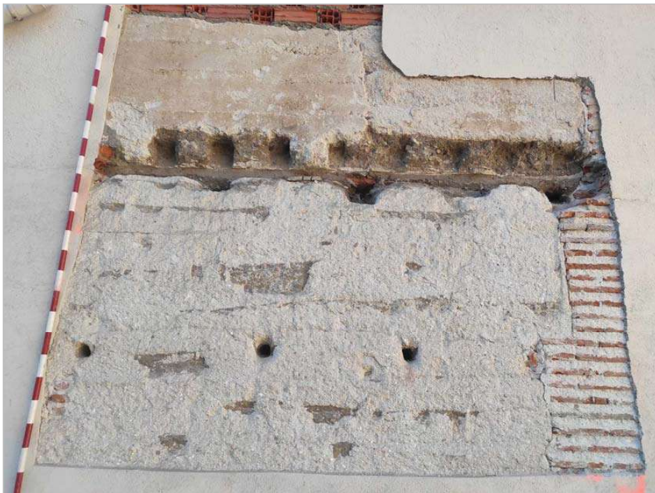
Figs. 81 a 83.- Dos fotografías del proceso de realización de la cata muraria y lo documentado en la misma; un muro de tapial con machones de ladrillos en el que se ven las improntas de unos mechinales donde apoyaría la estructura de madera de un tejadillo a un agua.
