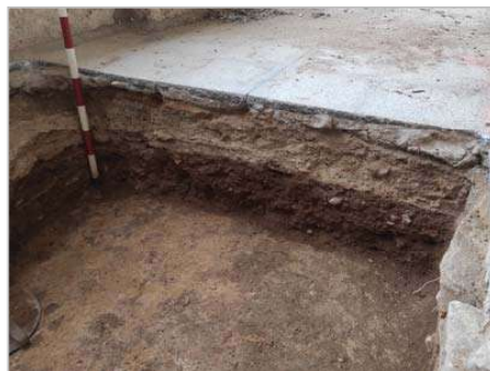
Figs. 66 y 67.- Izquierda, cimentación (UE. 103) del antepecho de la galería y la capa de argamasa (UE. 105) sobre la que se asentaba. Derecha, perfil oriental de la cata donde se ve el suelo actual de baldosas de gres y su capa de asiento de arena, la capa de asiento de mortero de cal del pavimento de baldosas de arenisca, el nivel de relleno de tonalidad oscura y la capa de argamasa de tonalidad anaranjada
