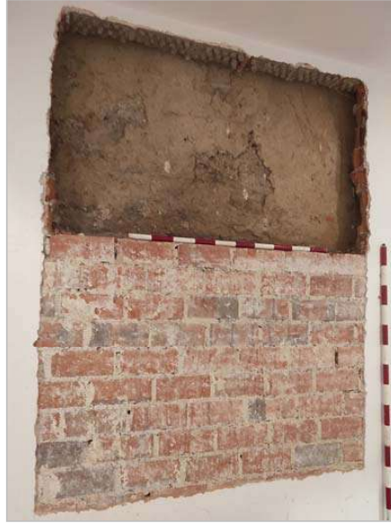
Figs. 95 y 96.- Izquierda, localización de las 2 catas trazadas en el muro E, la cata A en la mitad S (en primer plano) y la B en la mitad N (al fondo del pasillo). Derecha, la cata A donde tras retirar los ladrillos de la actual quedó a la luz el muro de tapial sin ninguna diferencia en su grosor.
