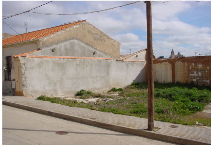
Vista desde calle Quevedo
