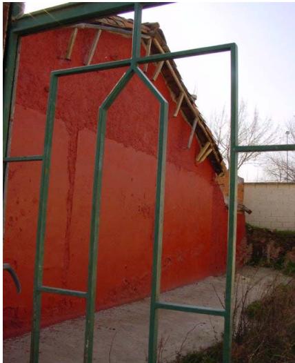
Interior de la parcela (medianeras)
