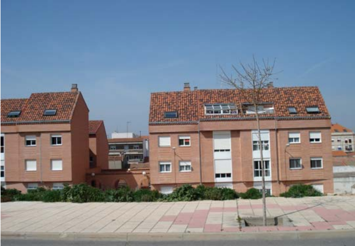
Vista 1 desde calle Cordel de Merinas
