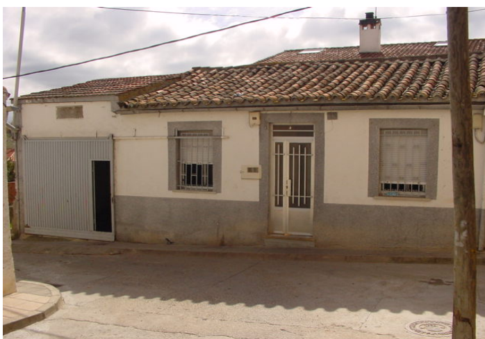
Fachada calle San Damián (parte habitada)
