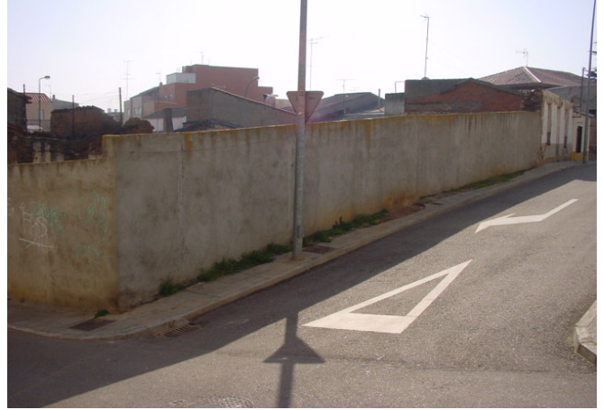
Fachada 2 vista desde calle del Matadero
