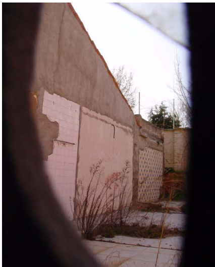
Interior de la parcela (medianeras)
