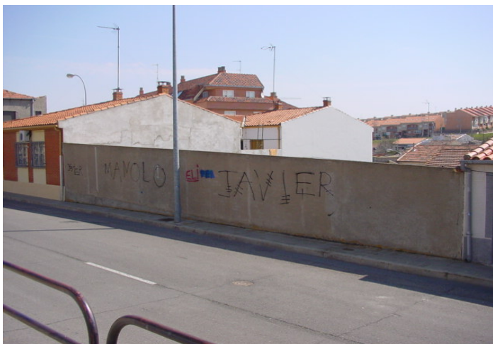
Fachada desde calle Mateo Hdez
