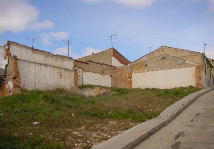
Vista desde calle de la Ladera
