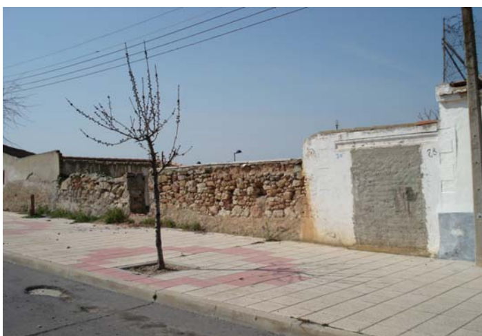
Vista desde calle Cordel de Merinas
