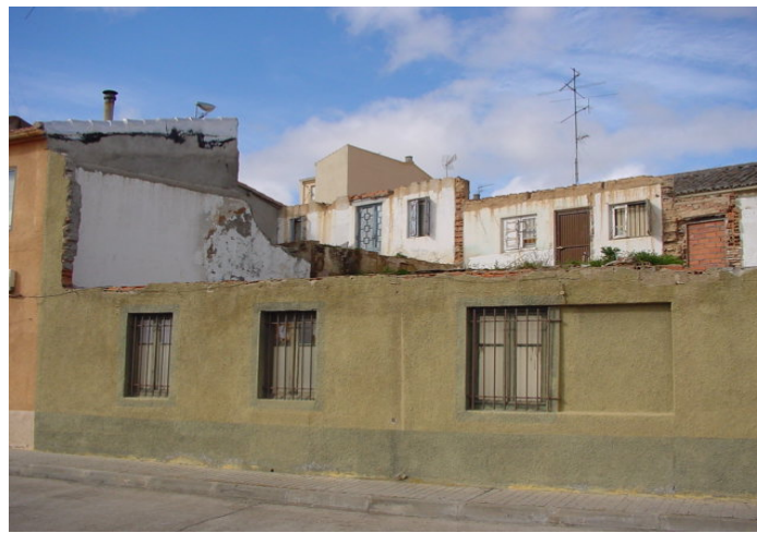
Vista de la fachada desde calle Quevedo
