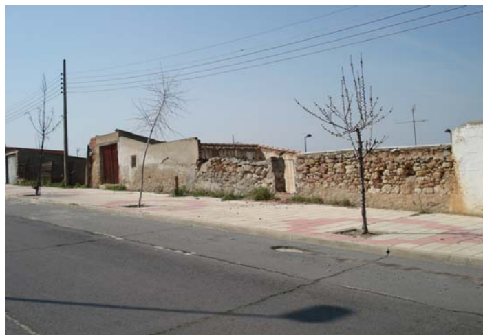
Vista desde calle Cordel de Merinas
