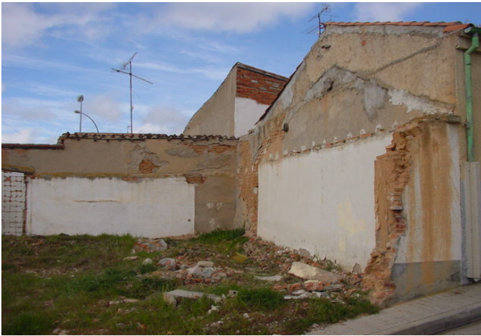
Vista desde calle de la Ladera
