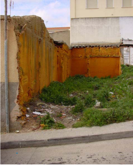
Vista desde calle de la Ladera
