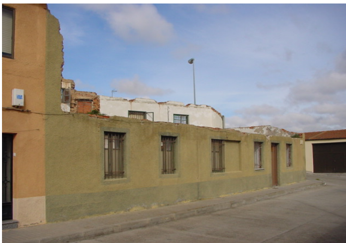
Vista de la fachada desde calle Quevedo
