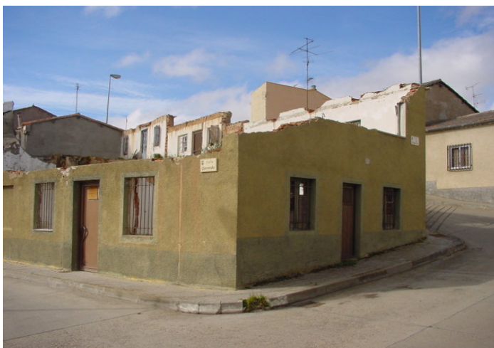
Vista de la fachada desde calle Quevedo
