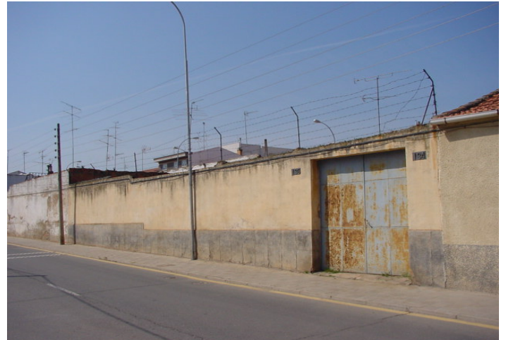
Fachada desde calle Mayor de Chamberí
