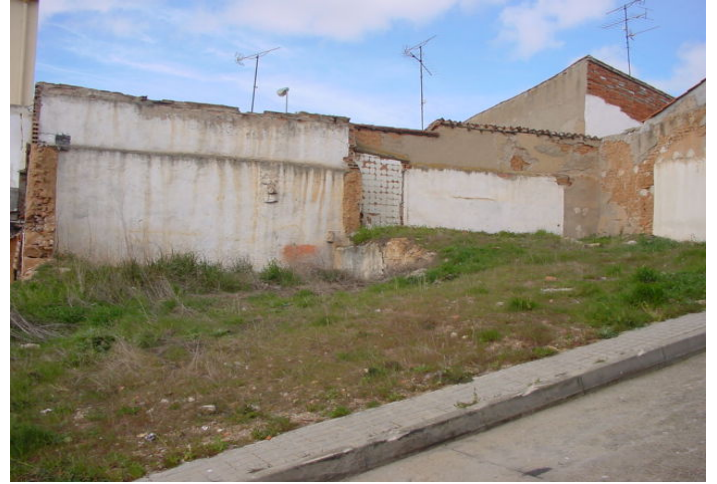
Vista desde calle de la Ladera
