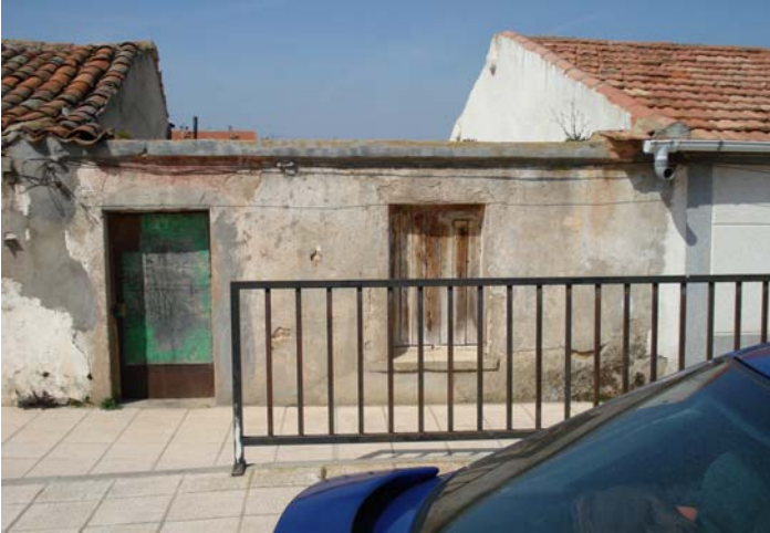
Vista 1 desde calle Cordel de Merinas
