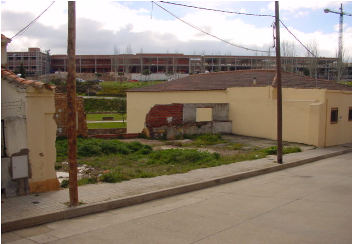
Vista desde calle Quevedo
