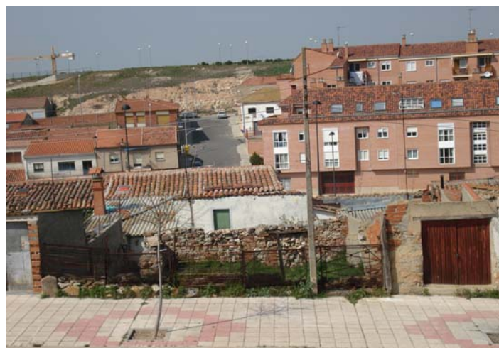
Vista desde calle Cordel de Merinas
