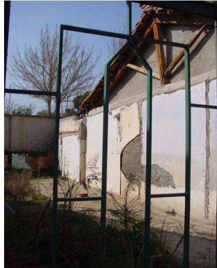
Interior de la parcela (medianeras)
