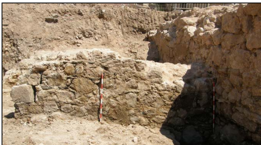
Muro UE 22. Paramento Sur.
