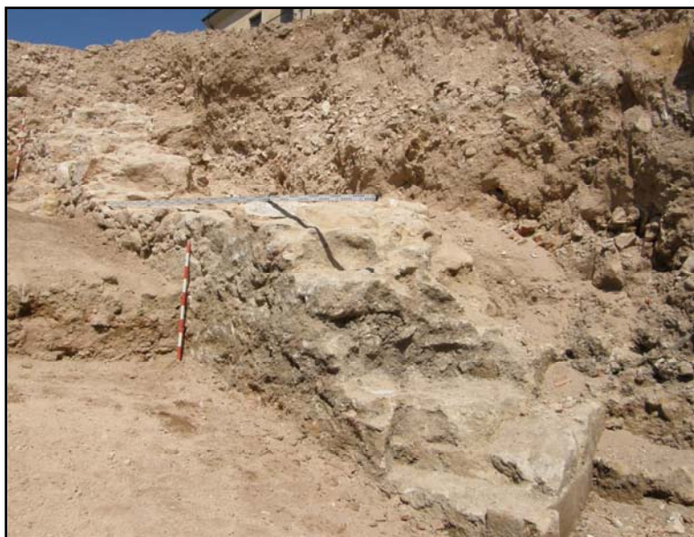
Muro UE 10. Paramento Sur.
