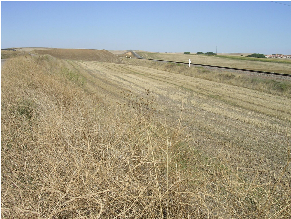
Foto 18 Sector entre Cordel de Medina y FFCC Salamanca-Medina del Campo
