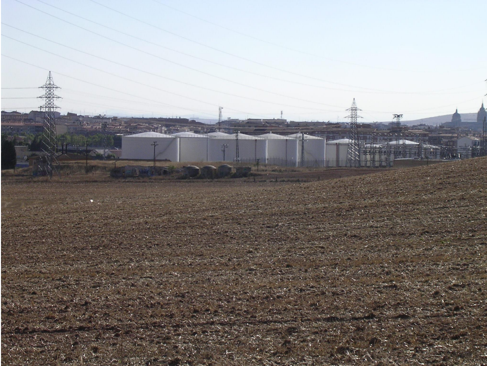
Foto 27 CLH y Centro de transformación
