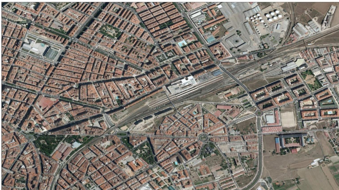
Estación de ferrocarril en el Paseo de la Estación.
