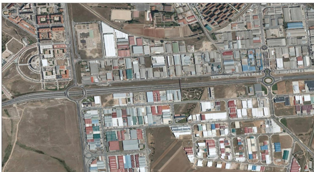
Polígono Industrial El Montalvo I y II.
